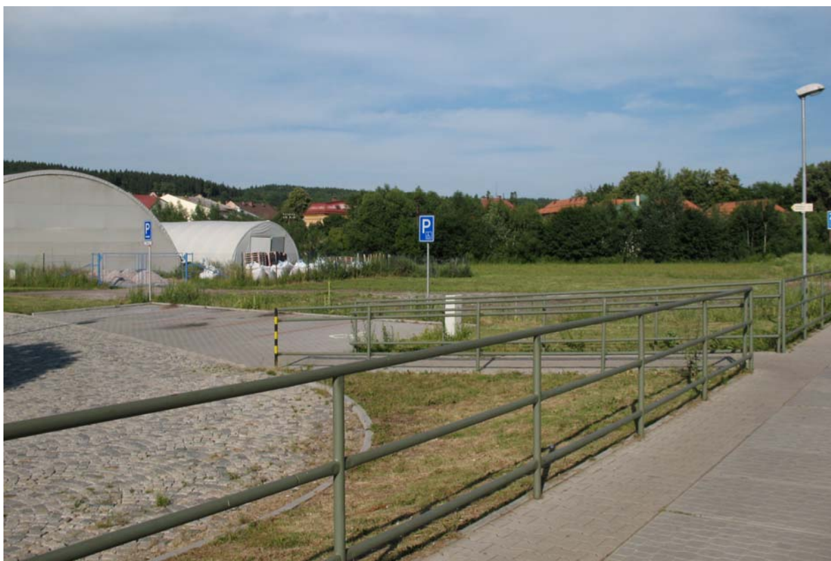
Obrázek 4: Boční rampa na nástupiště a parkoviště
