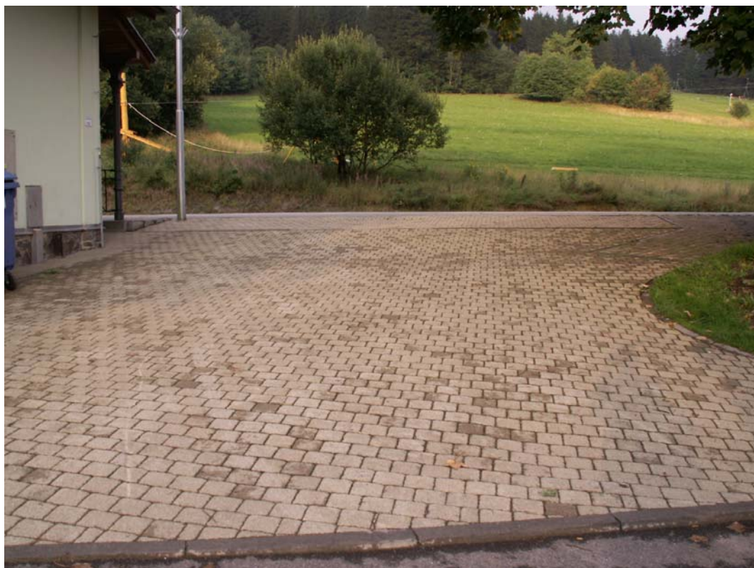
Obrázek 2: Bezbariérový přístup na nástupiště a k budově
