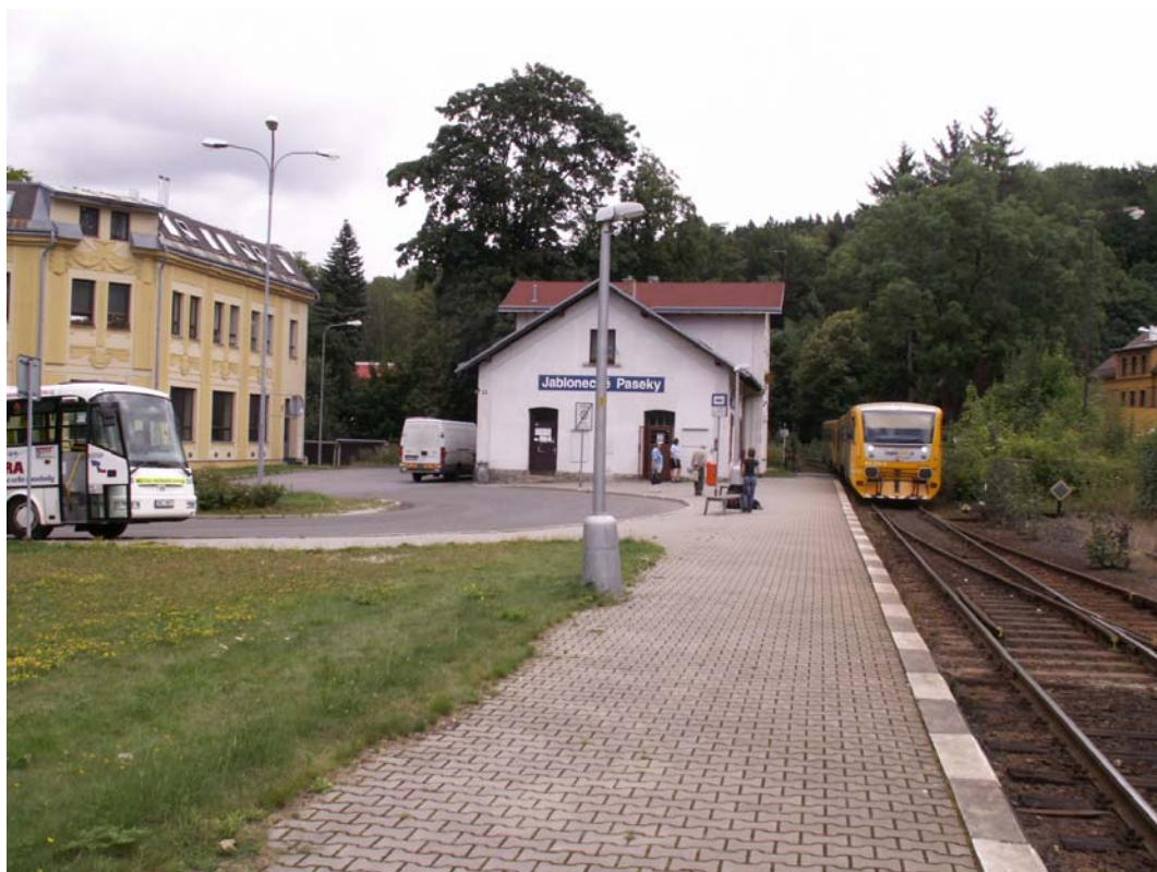
Obrázek 1: Celkový pohled na přestupní bod
