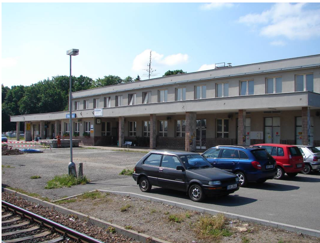
Obrázek 1: Výpravní budova, krytá veranda
