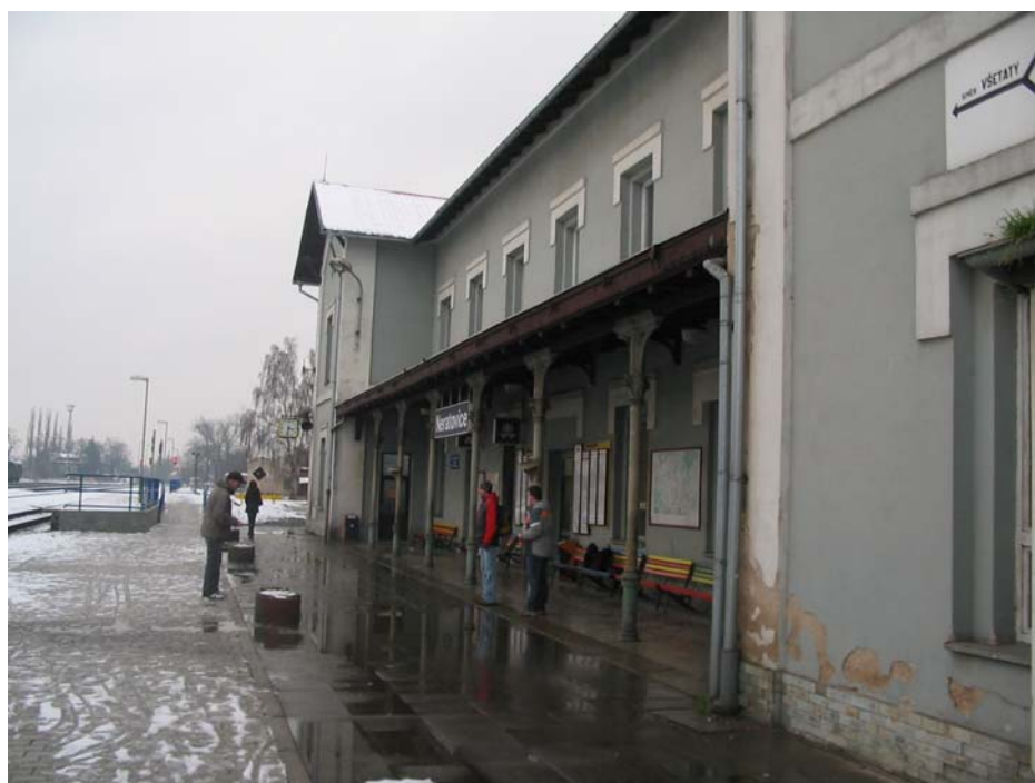
Obrázek 4: Prostor před výpravní budovou
