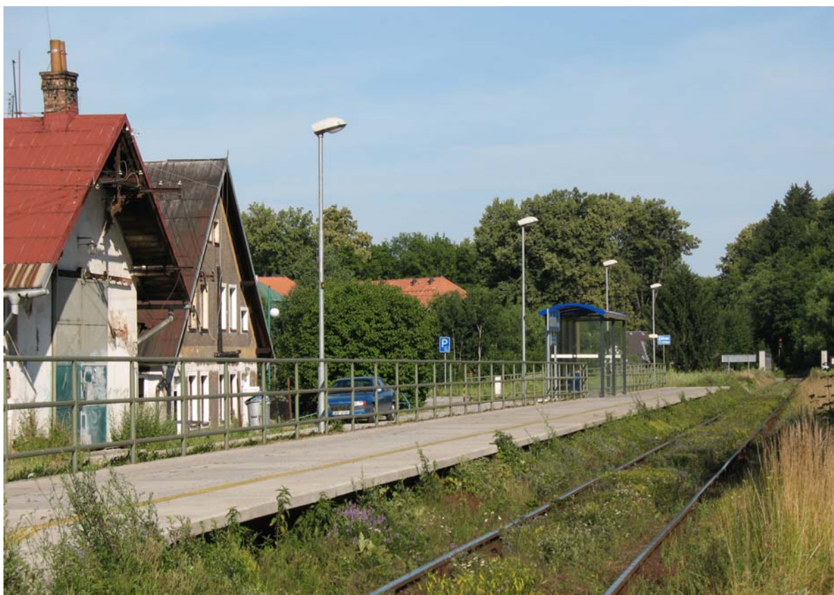
Obrázek 2: Celkový pohled na nástupiště s přístřeškem
