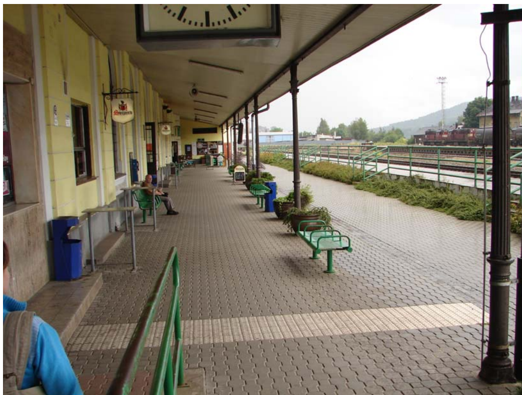
Obrázek 1: Výpravní budova, krytá veranda
