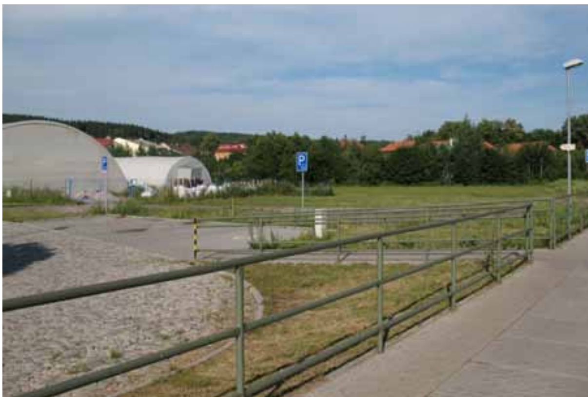
Obrázek 4: Boční rampa na nástupiště a parkoviště
