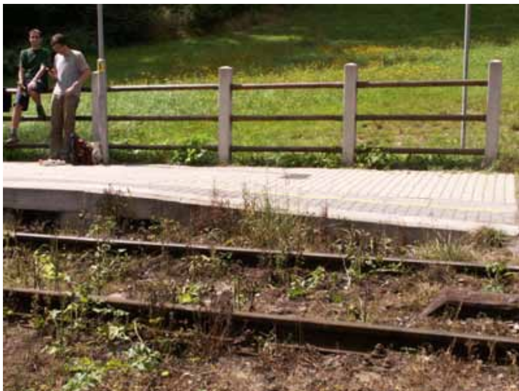
Obrázek 3: Přístup šikmou rampou od pozemní komunikace
