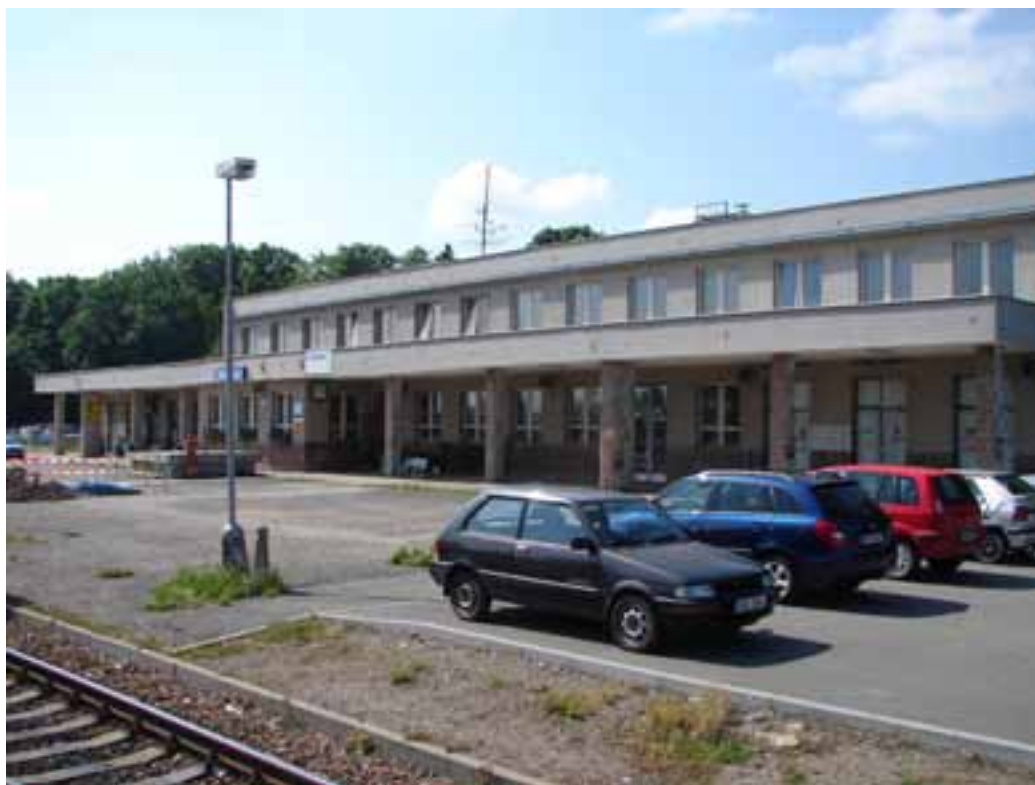
Obrázek 1: Výpravní budova, krytá veranda
