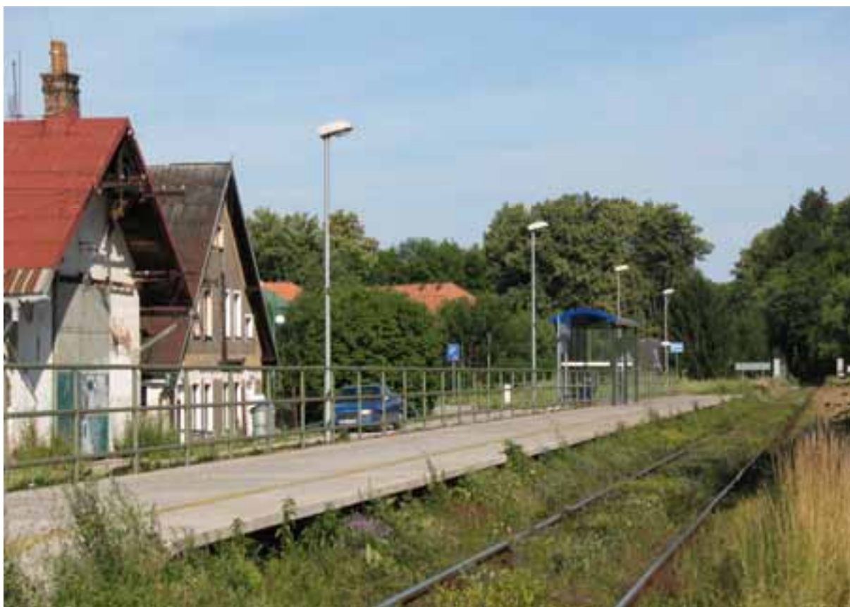
Obrázek 2: Celkový pohled na nástupiště s přístřeškem
