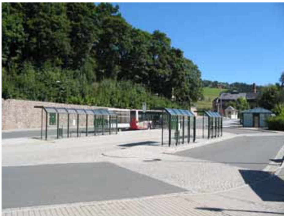
Obrázek 3: Stanoviště autobusů v přednádraží
