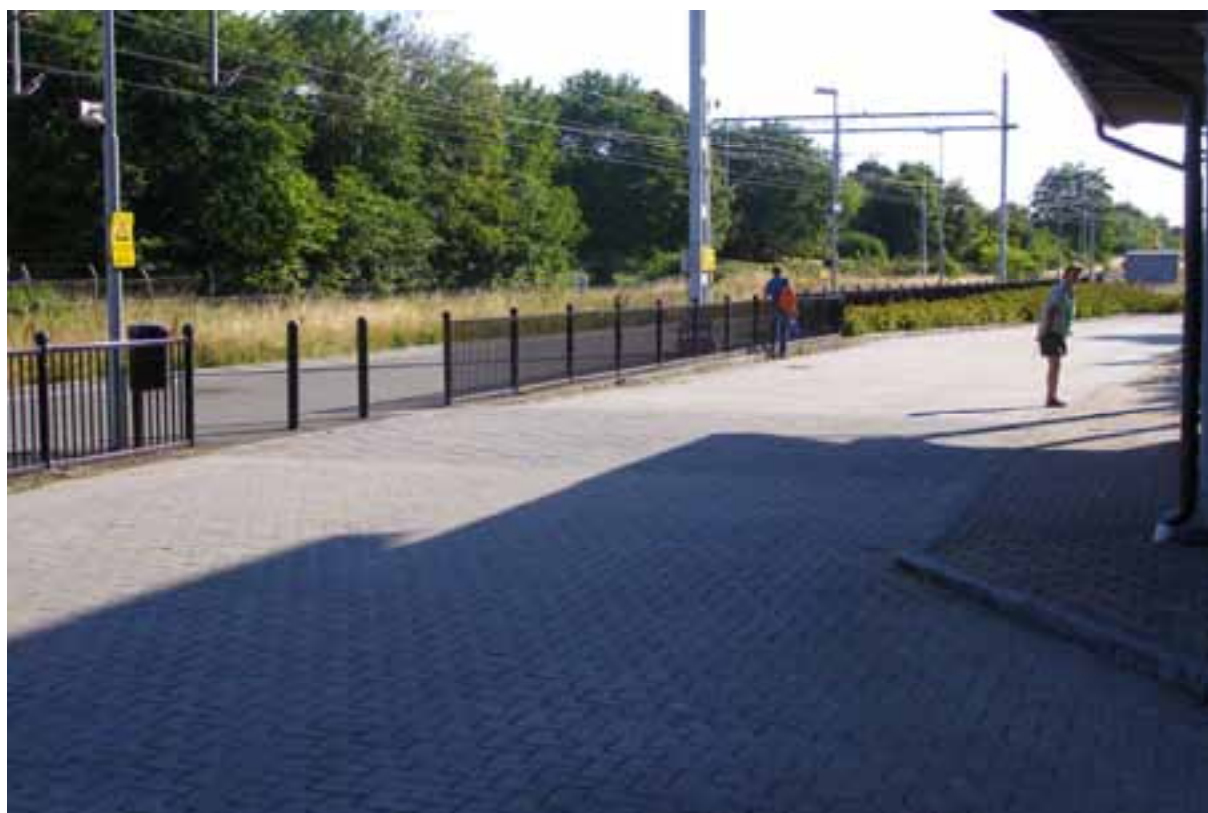
Obrázek 4: Detail zvýšeného přechodu přes komunikaci pro autobusy mezi verandou u výpravní budovy a nástupištěm
