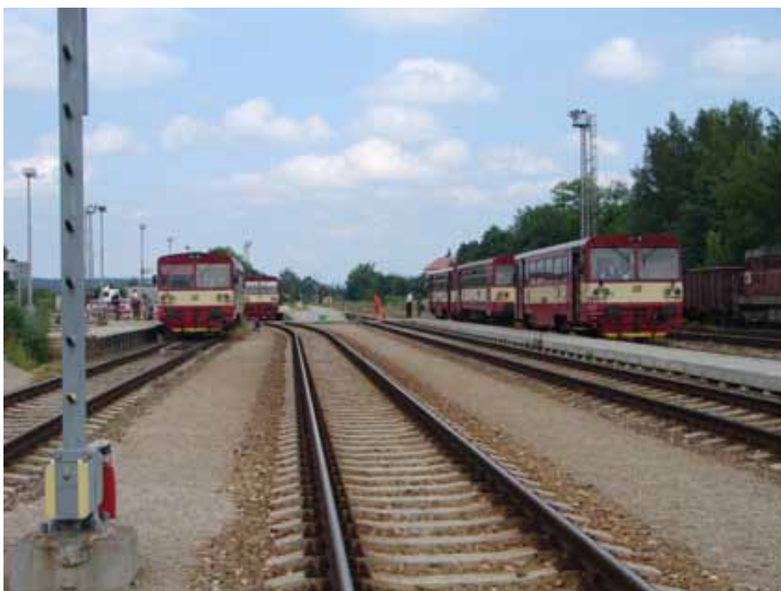
Obrázek 4: Celkový pohled (ze směru Protivín, Strakonice)
