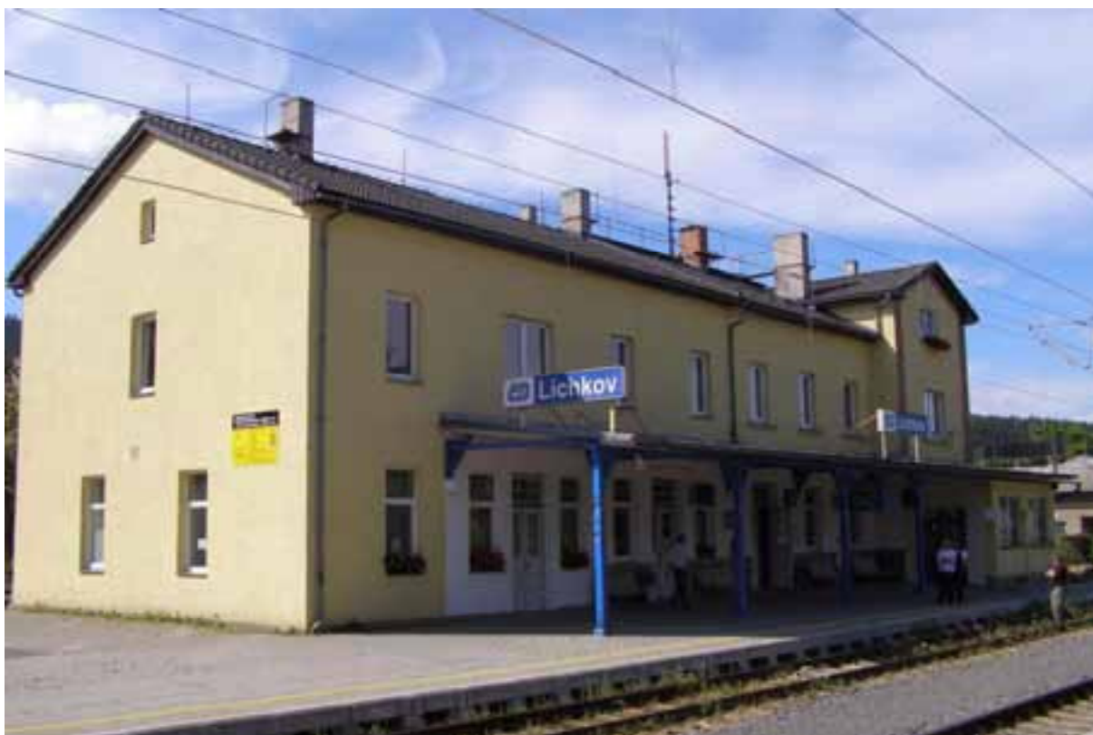
Obrázek 1: Výpravní budova, krytá veranda
