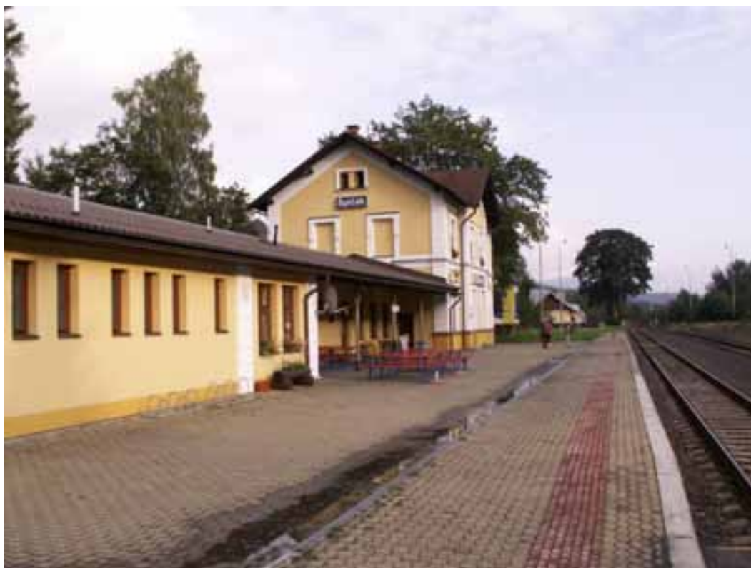
Obrázek 1: Výpravní budova, krytá veranda
