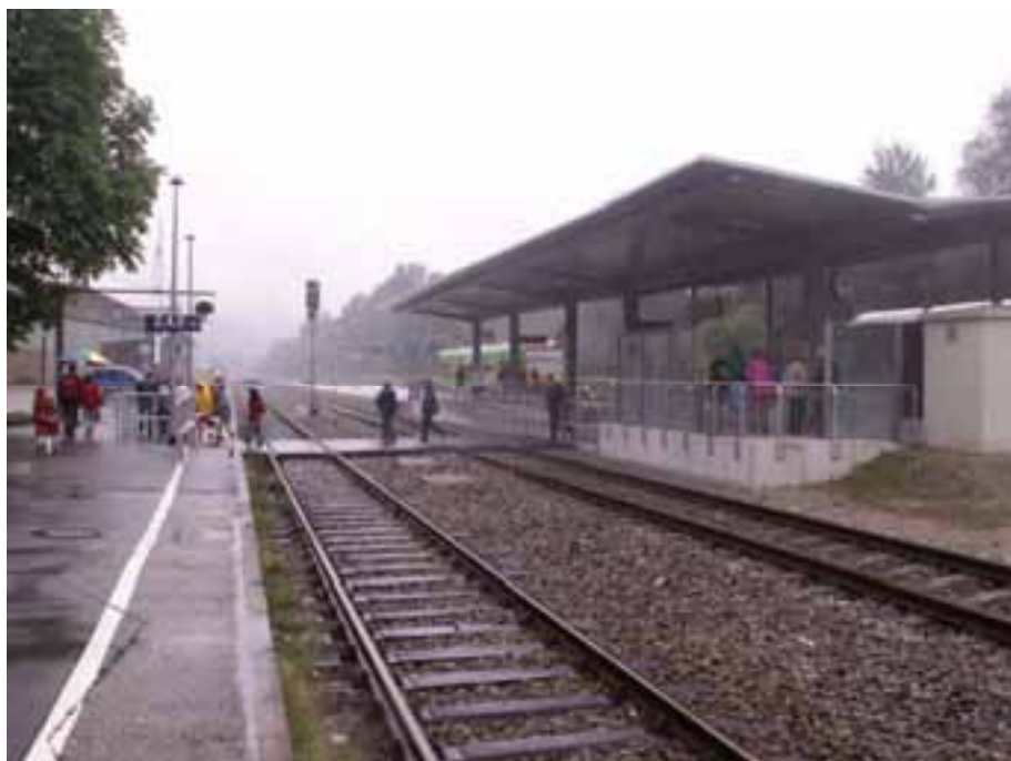
Obrázek 3: Celkový pohled na nástupiště
