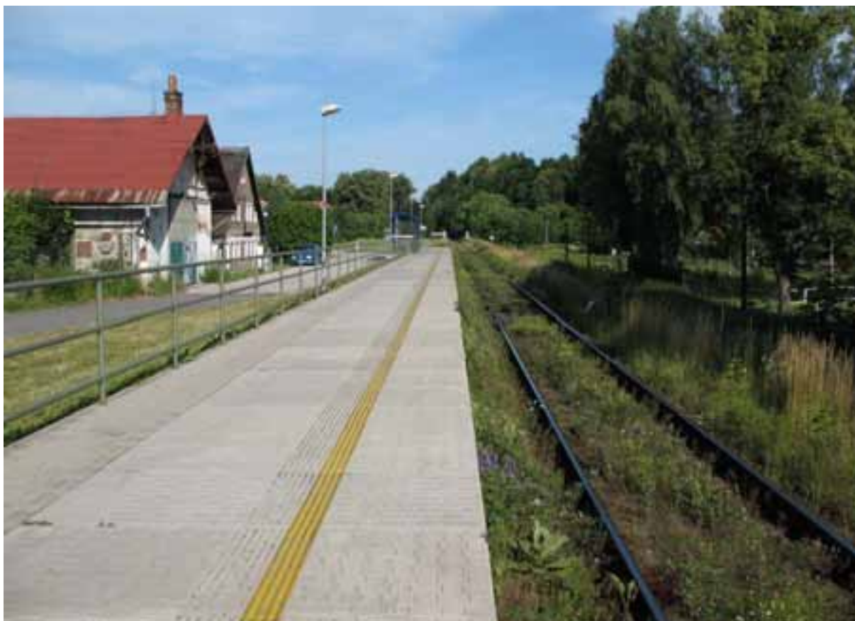
Obrázek 3: Celkový pohled na nástupiště
