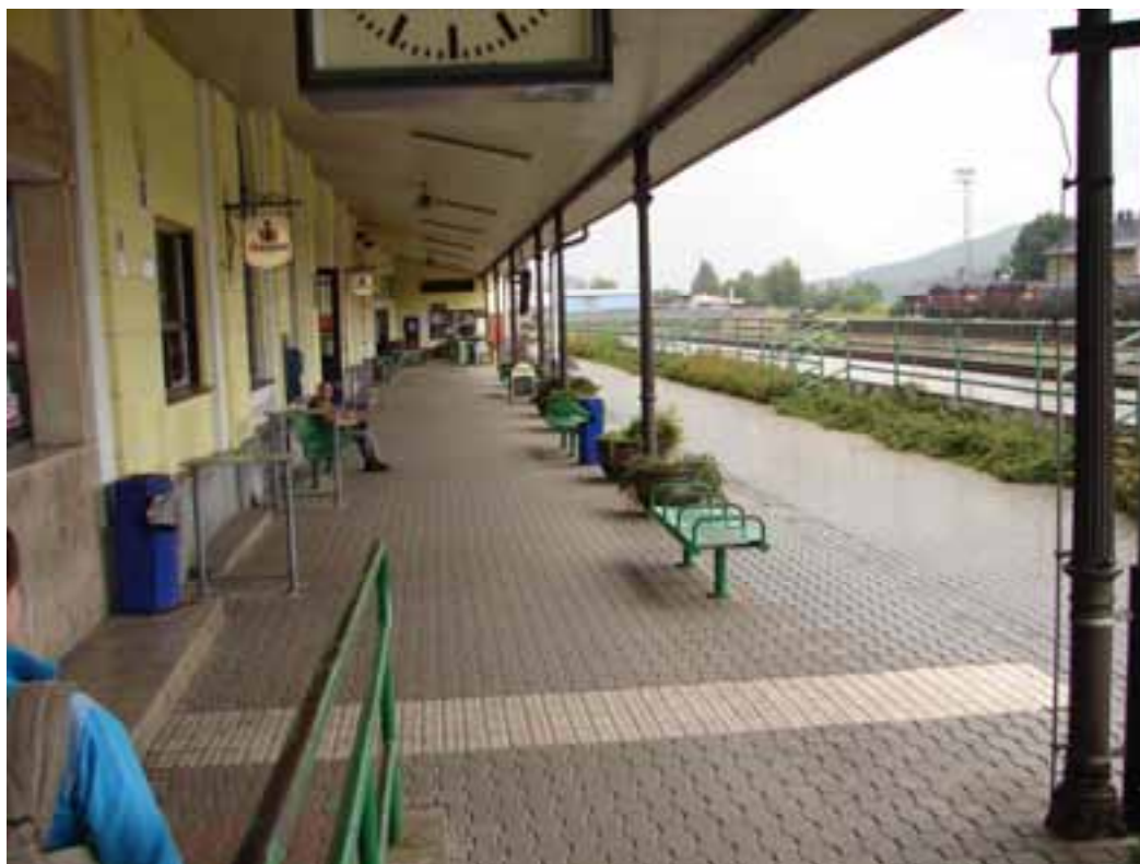
Obrázek 1: Výpravní budova, krytá veranda
