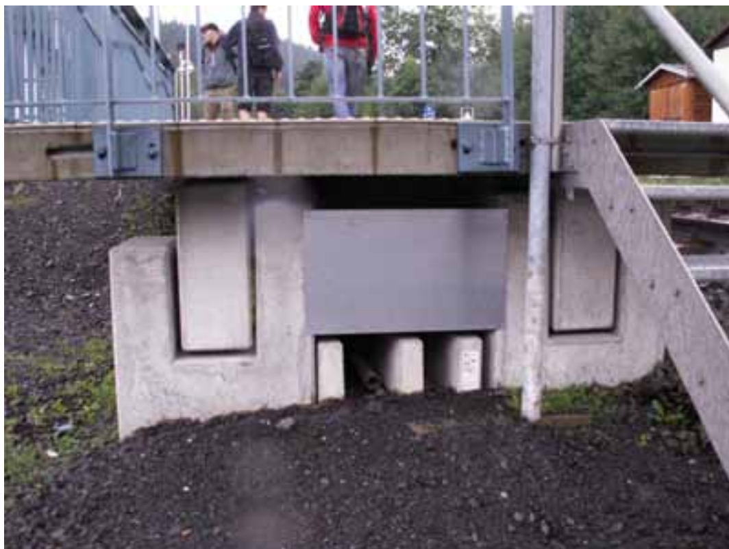
Obrázek 4: Detail konstrukce nástupiště
