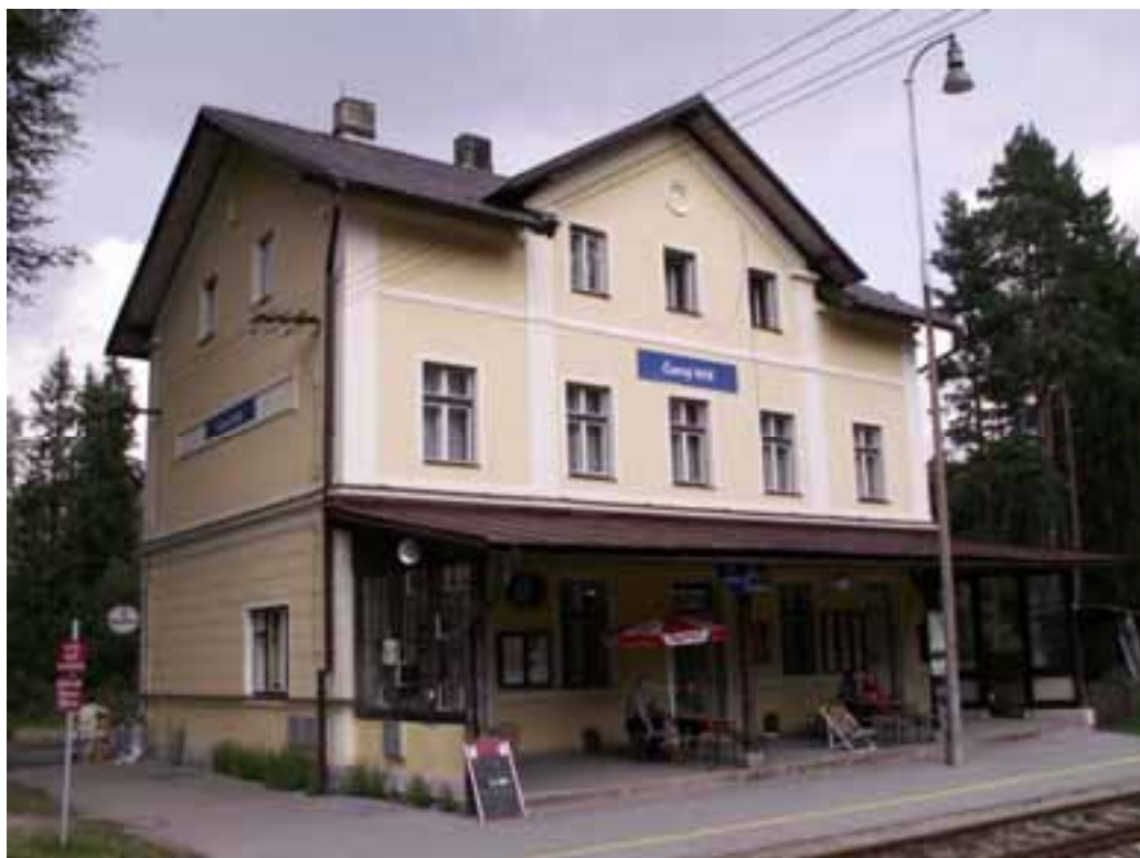
Obrázek 1: Výpravní budova, krytá veranda
