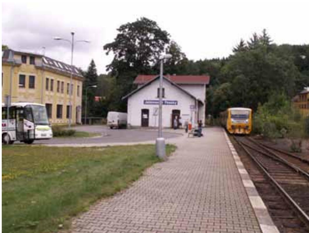
Obrázek 1: Celkový pohled na přestupní bod
