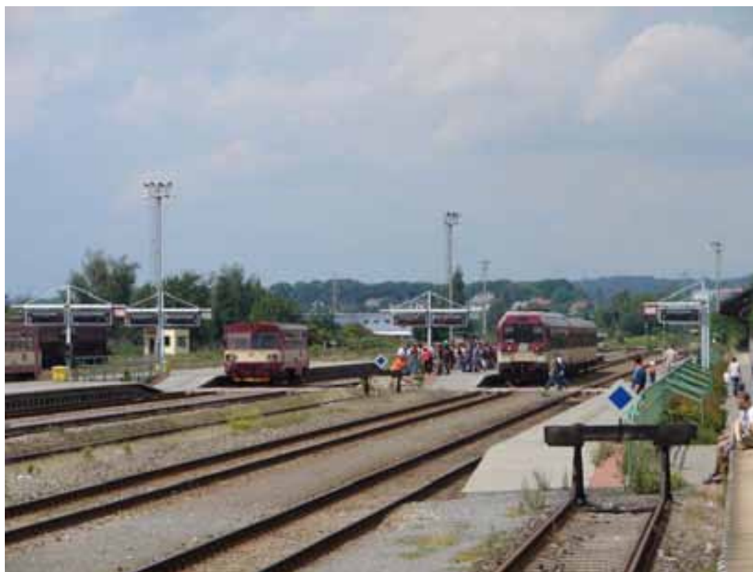
Obrázek 4: Celkový pohled na nástupiště
