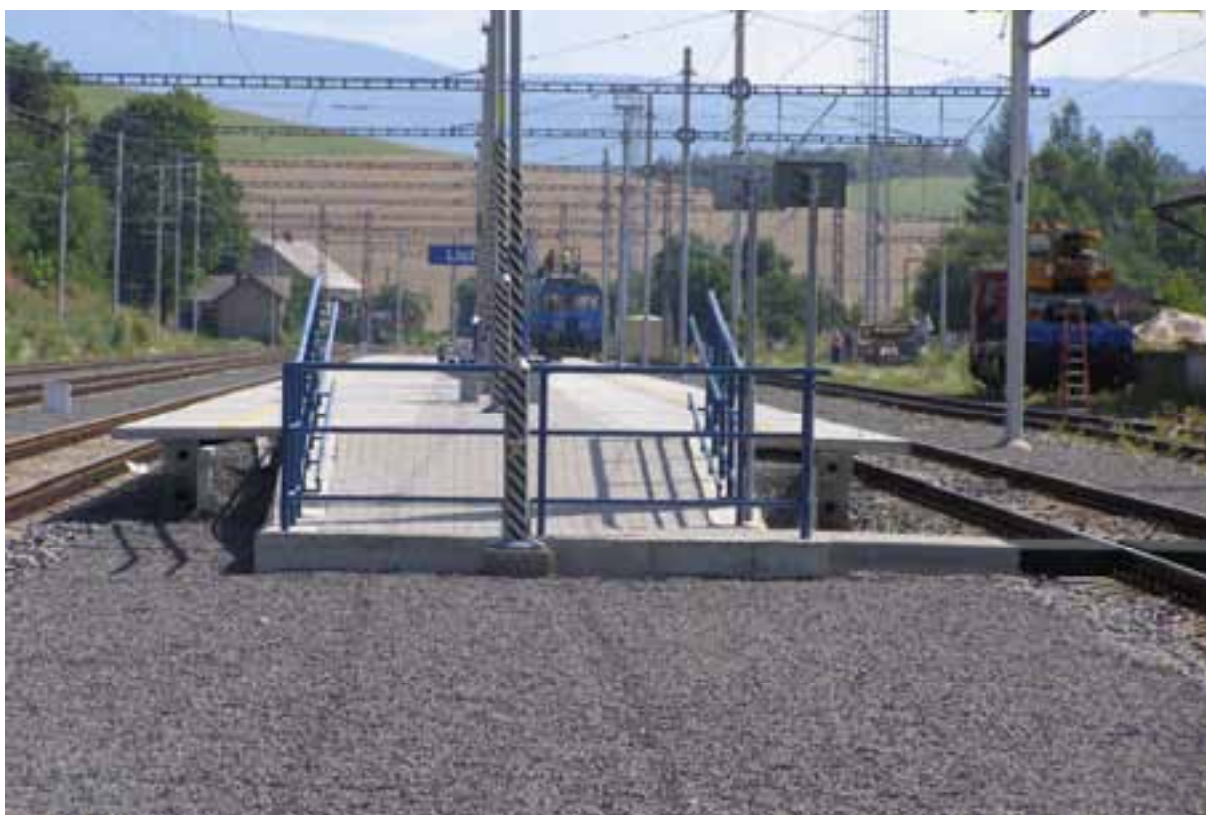
Obrázek 4: Přístup na nástupiště č. II
