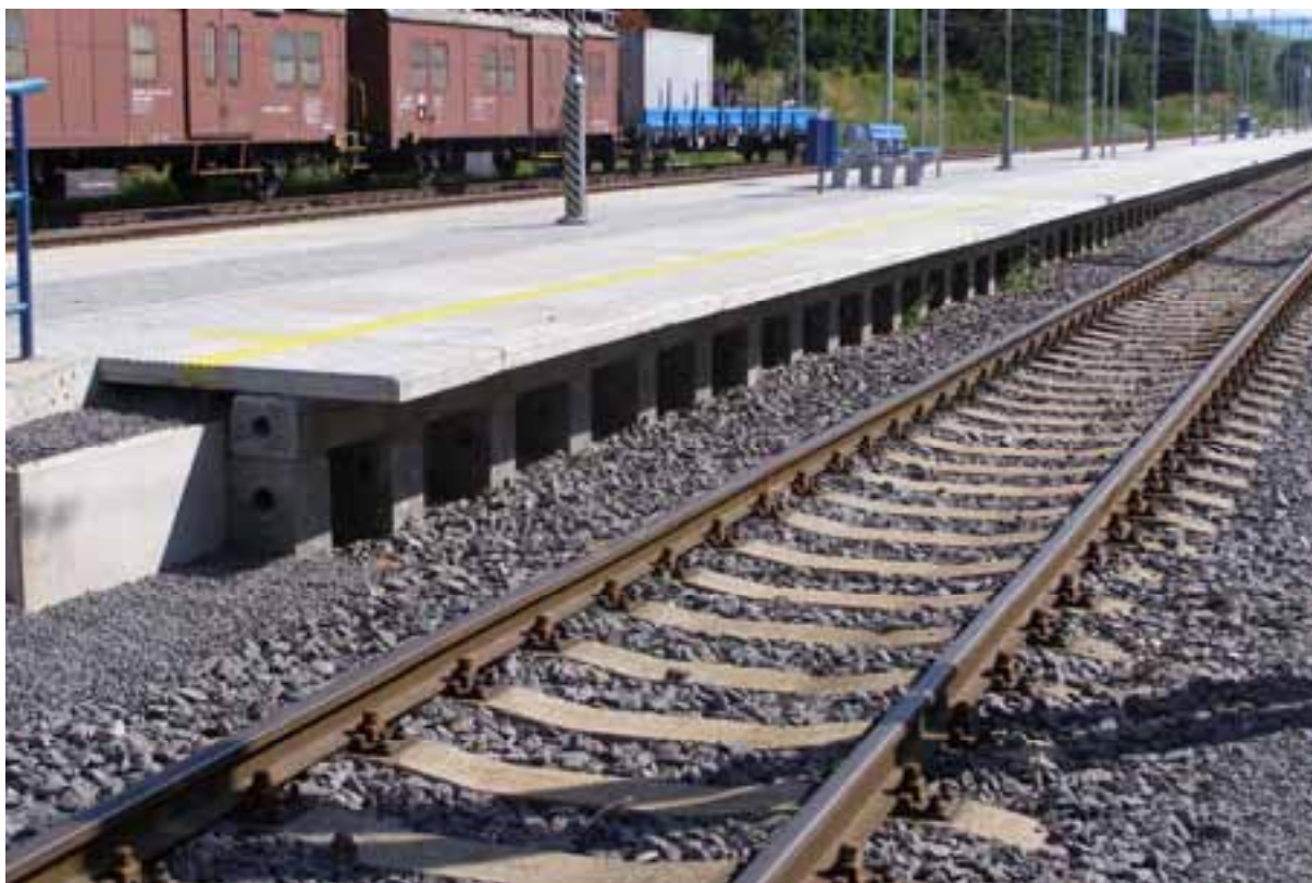
Obrázek 3: Nástupiště č. II (oboustranné s úrovnňovým přístupem)
