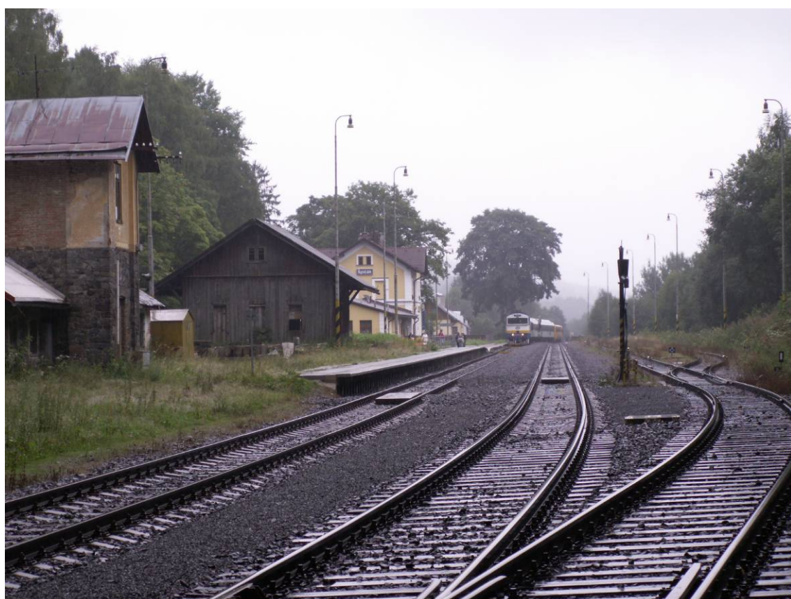
Obrázek 4: Celkový pohled (ze směru Plzeň)
