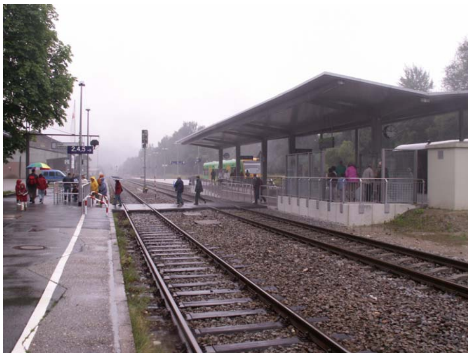
Obrázek 3: Celkový pohled na nástupiště
