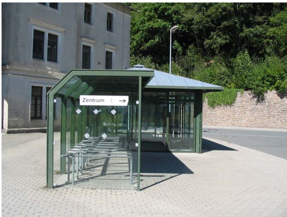
Obrázek 4: Přístřešek pro cestující a jízdní kola
