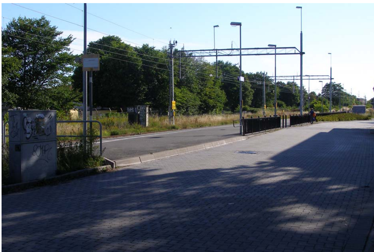
Obrázek 2: Vnější nástupiště a komunikace pro autobusy, zvýšený přechod
