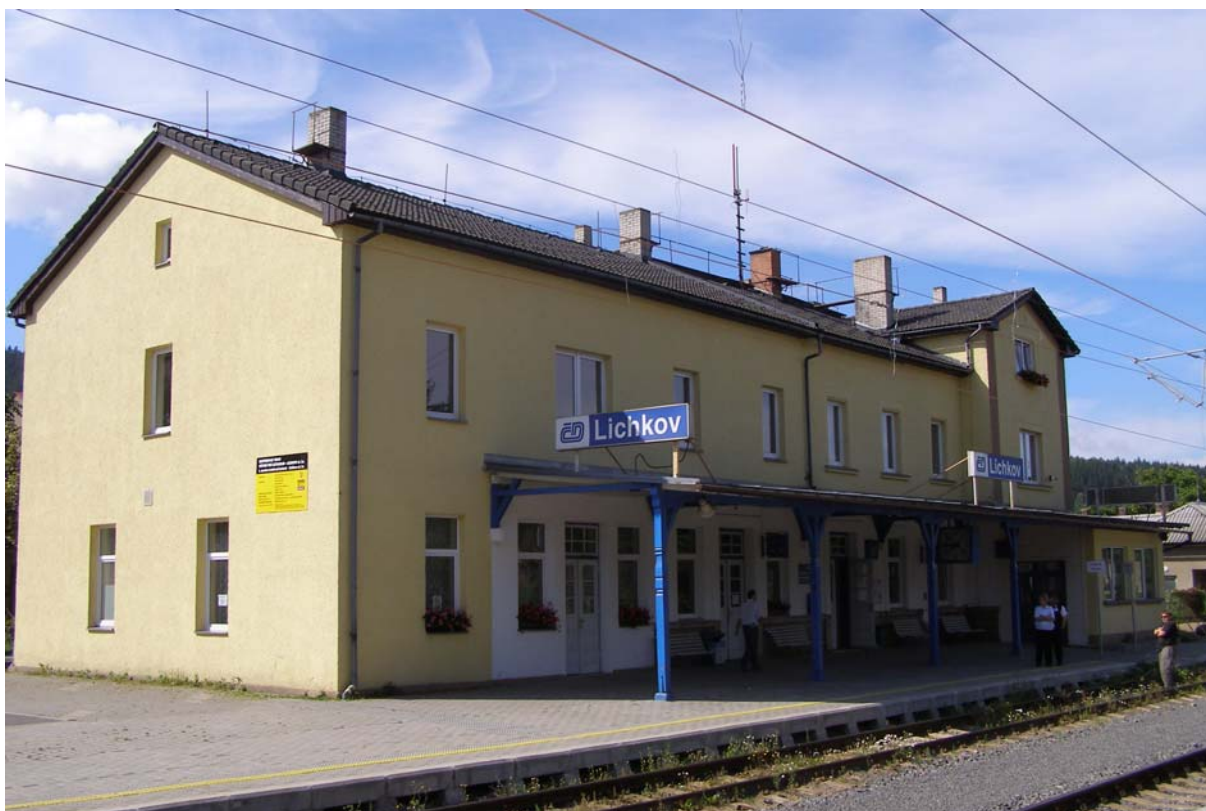
Obrázek 1: Výpravní budova, krytá veranda
