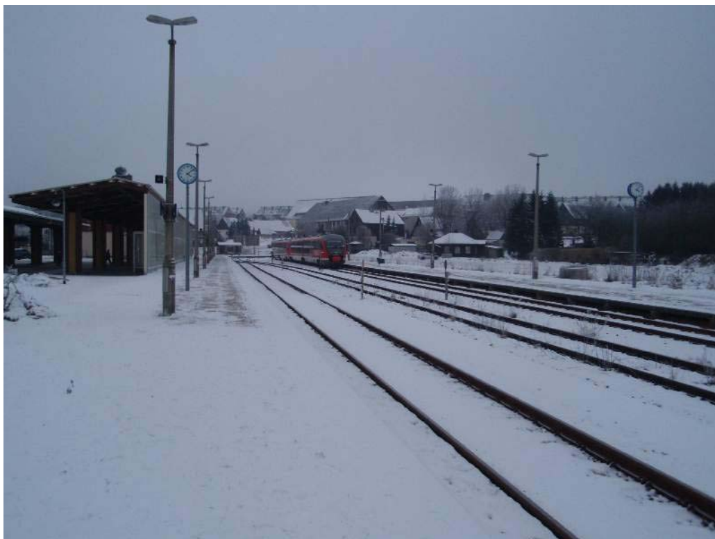
Obrázek 1: Celkový pohled na stanici od heidenauského zhlaví
