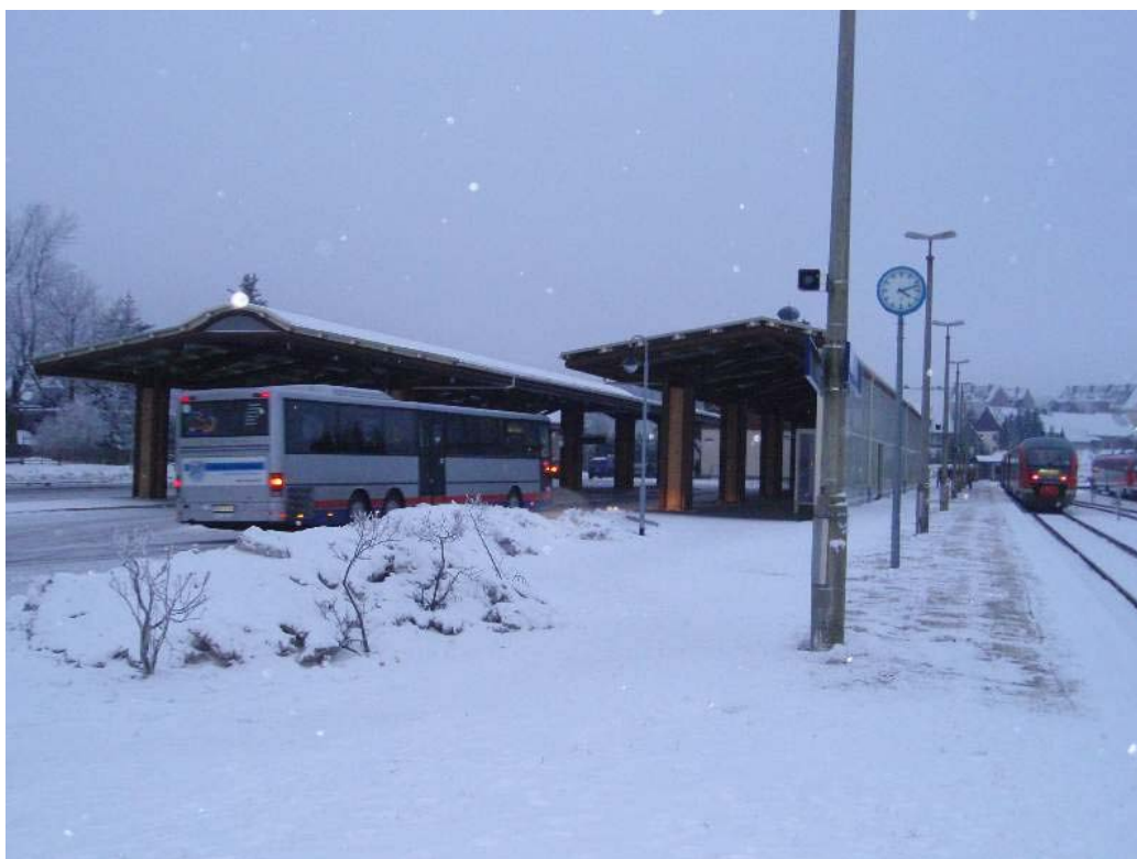
Obrázek 2: Autobusový terminál, umístěný v těsném sousedství I. nástupiště
