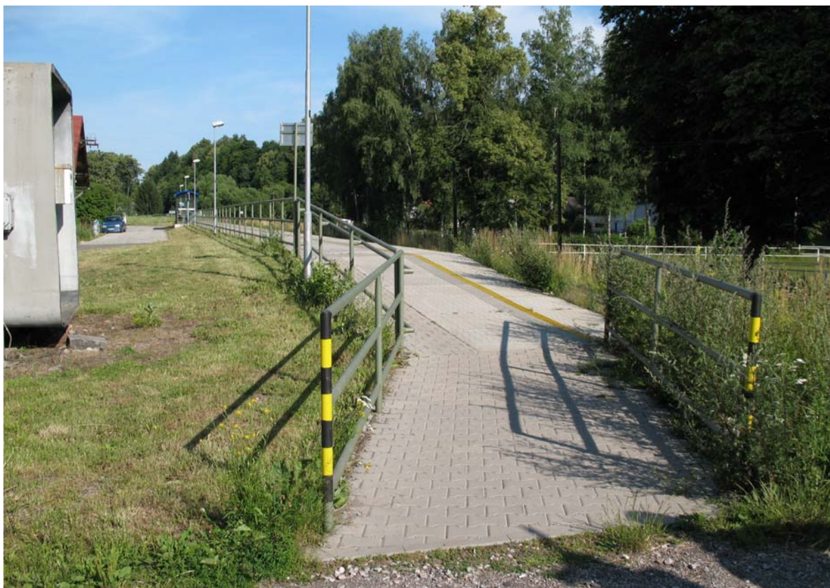
Obrázek 1: Přístup čelní rampou na vnější nástupiště
