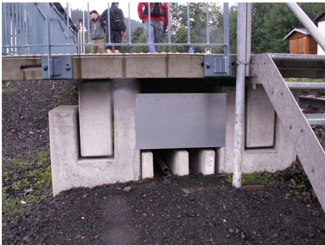
Obrázek 4: Detail konstrukce nástupiště
