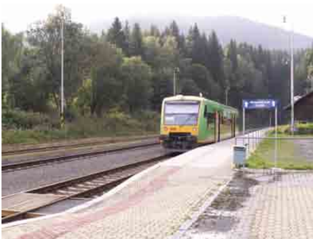
Obrázek 2: Nástupištní předěl – rampa k úrovněnému přechodu
