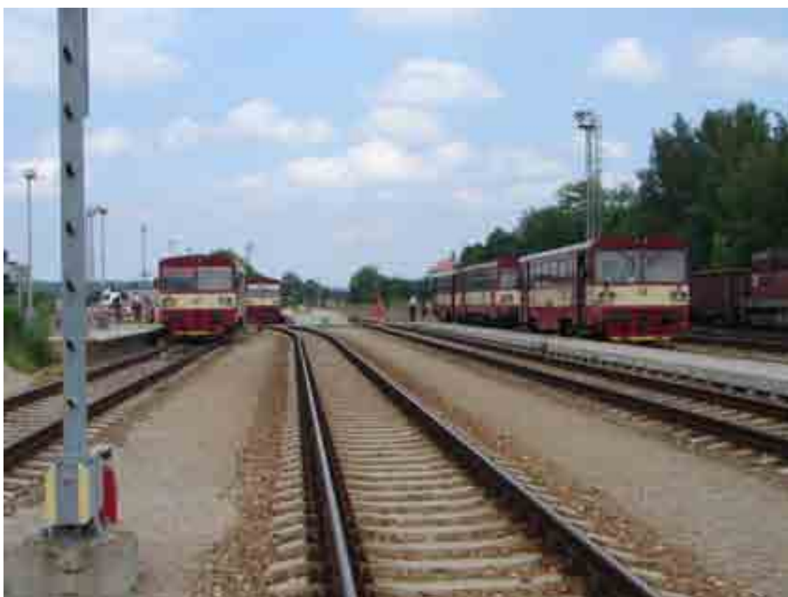
Obrázek 4: Celkový pohled (ze směru Protivín, Strakonice)
