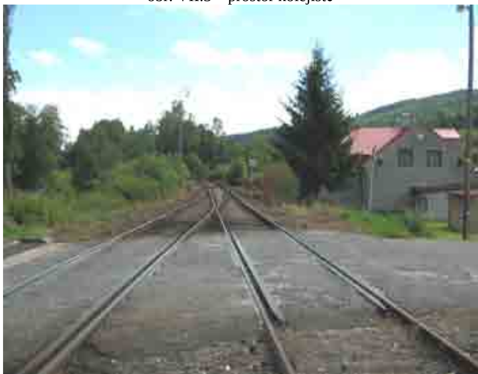
obr. VII.4 – železniční přejezd v prostoru zhlaví
