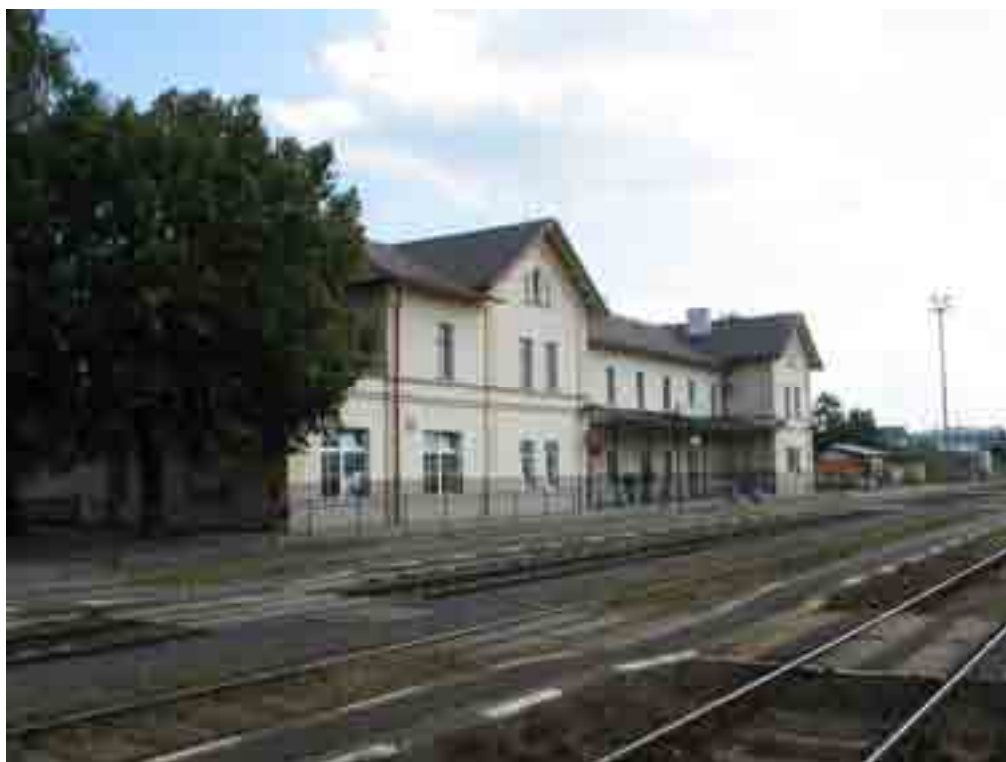
obr. IV.1 – pohled na výpravní budovu
