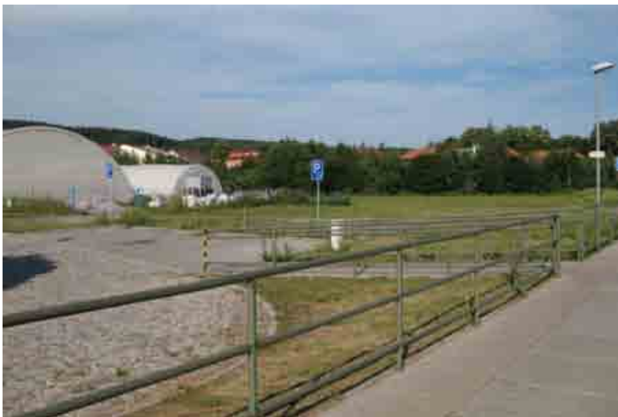
Obrázek 4: Boční rampa na nástupiště a parkoviště
