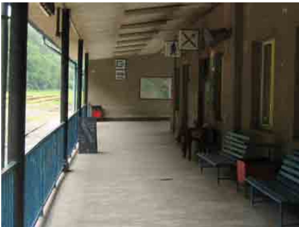
obr. V.3 – přístřešek výpravní budovy
