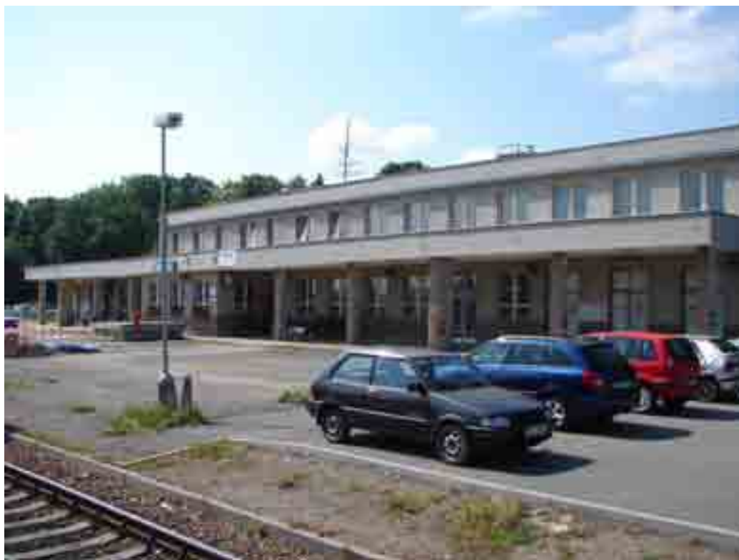
Obrázek 1: Výpravní budova, krytá veranda
