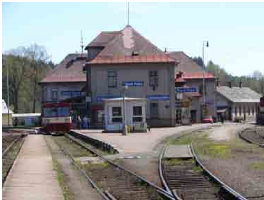
obr. XIV.1 – pohled na výpravní budovu a nástupištní klín
