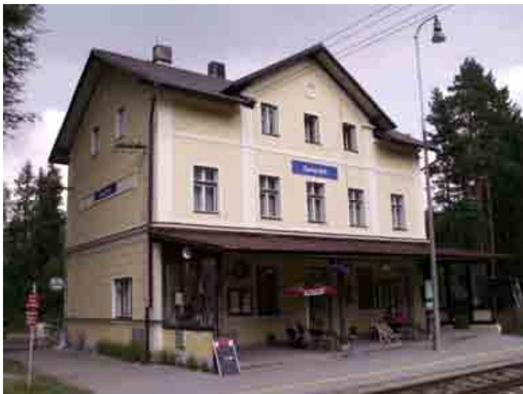
Obrázek 1: Výpravní budova, krytá veranda
