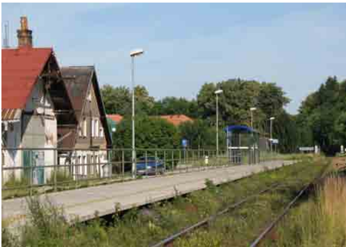
Obrázek 2: Celkový pohled na nástupiště s přístřeškem
