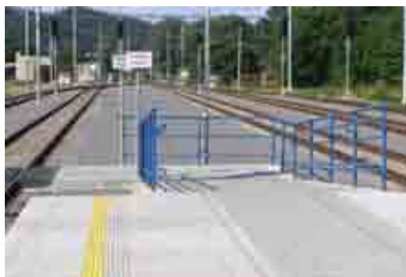
Obr. 3.15 – Šikmá rampa doplněná zábradlím
