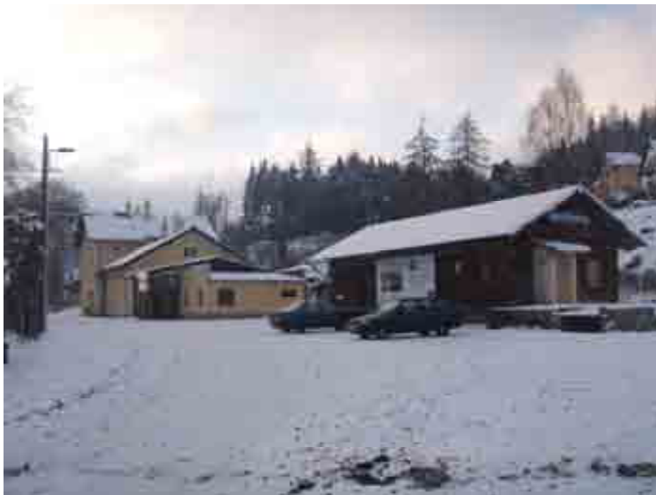
obr. XIII.3 – prostor přednádraží, boční rampa se skladem
