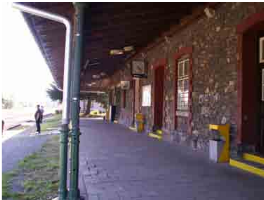
obr. XVII.3 – přístřešek u výpravní budovy
