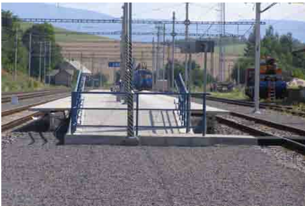
Obrázek 4: Přístup na nástupiště č. II
