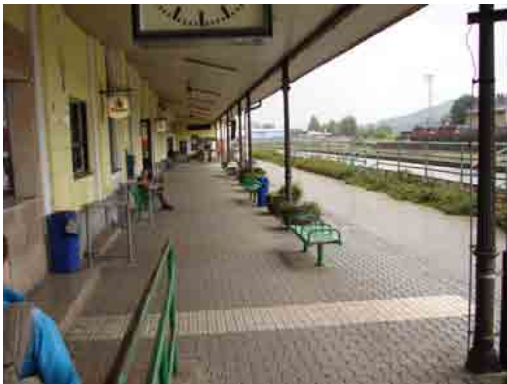
Obrázek 1: Výpravní budova, krytá veranda
