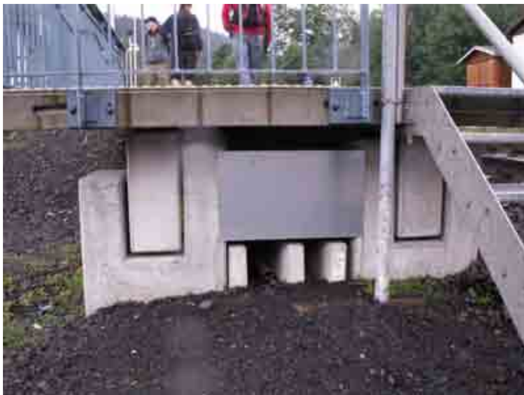
Obrázek 4: Detail konstrukce nástupiště
