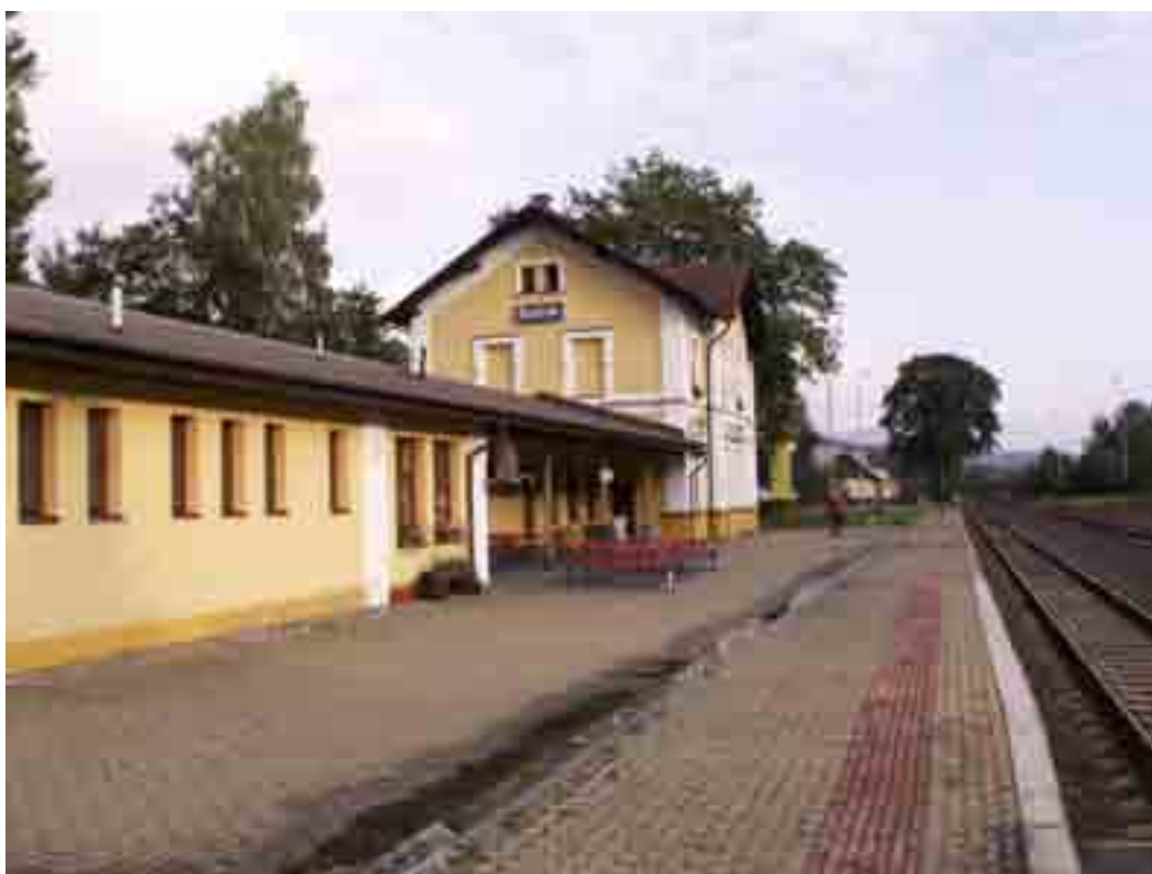
Obrázek 1: Výpravní budova, krytá veranda
