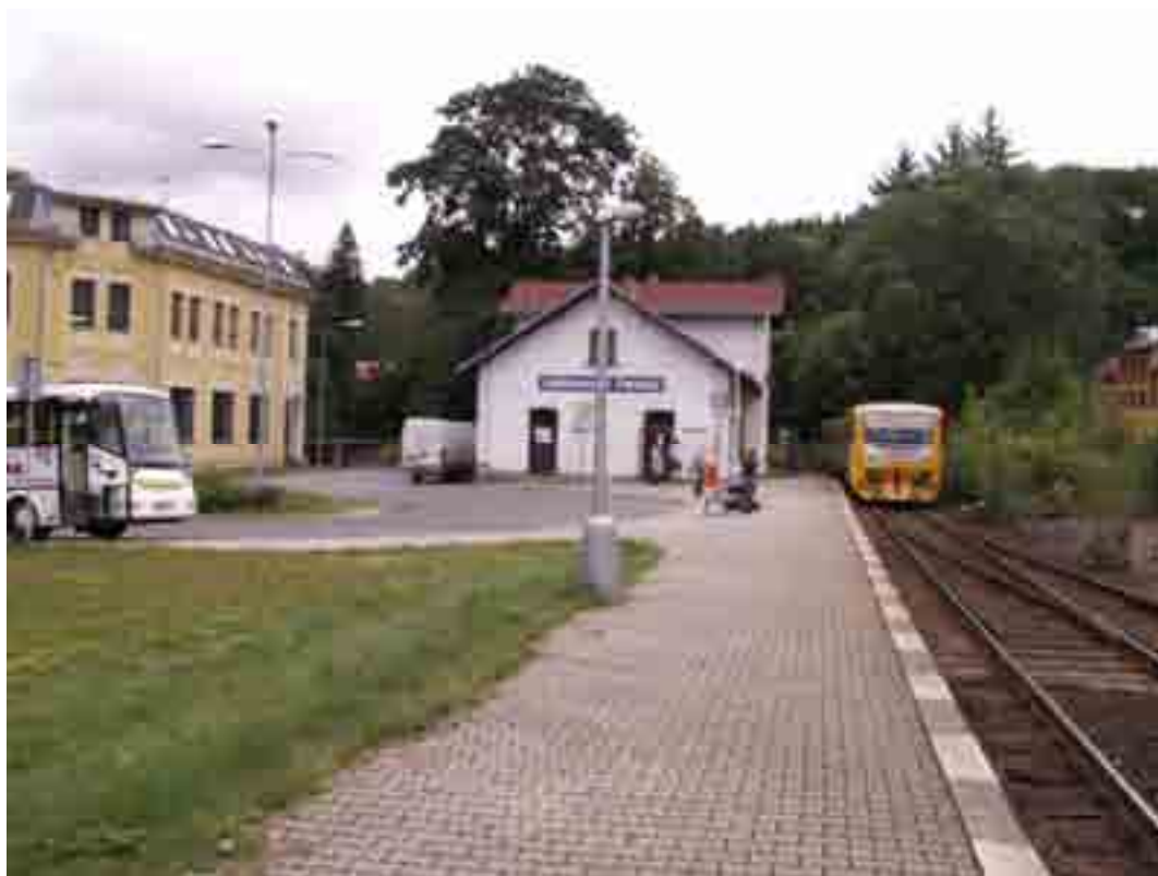
Obrázek 1: Celkový pohled na přestupní bod
