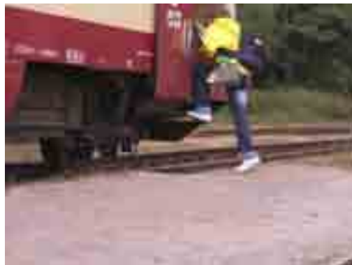
Obr. 3.1 – Úrovňové sypané nástupiště (silně podudržované)
