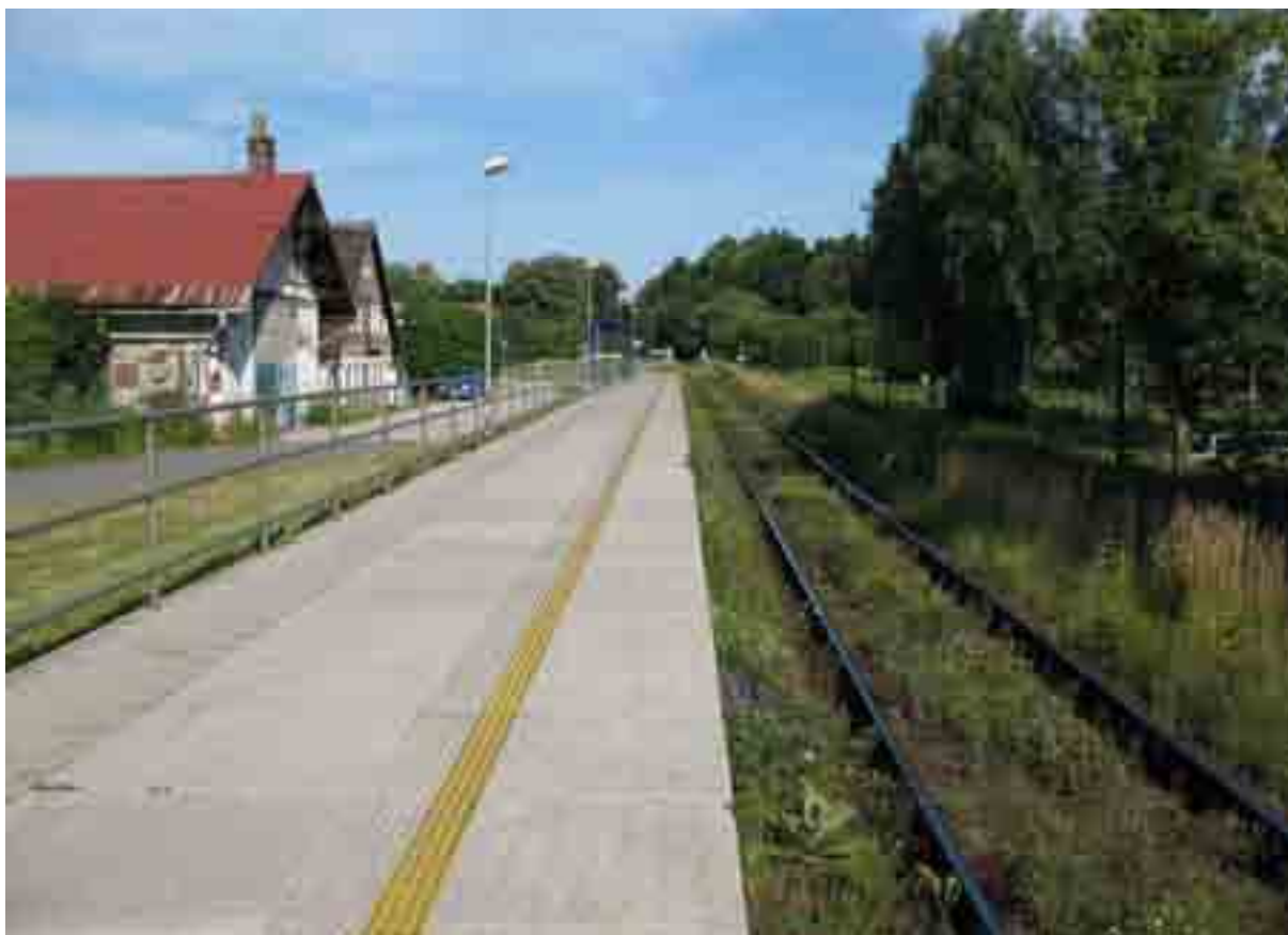
Obrázek 3: Celkový pohled na nástupiště
