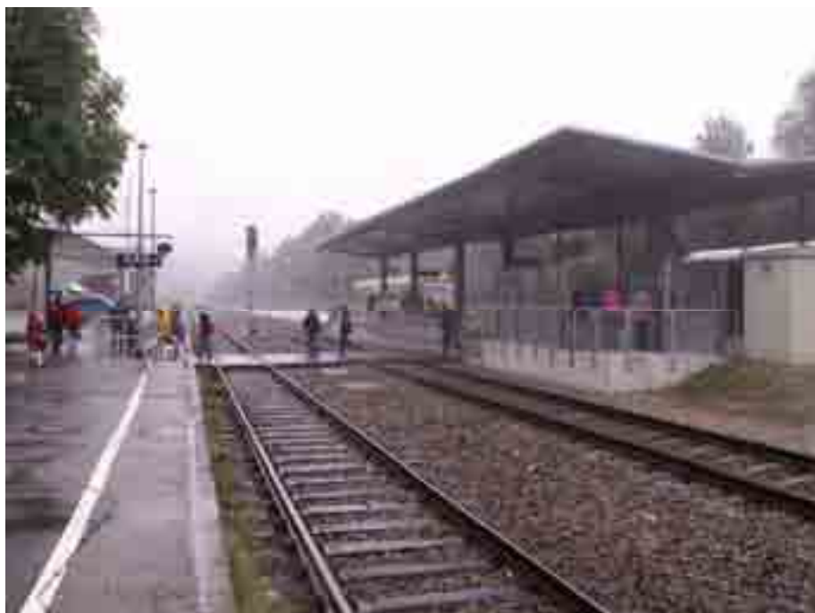
Obrázek 3: Celkový pohled na nástupiště
