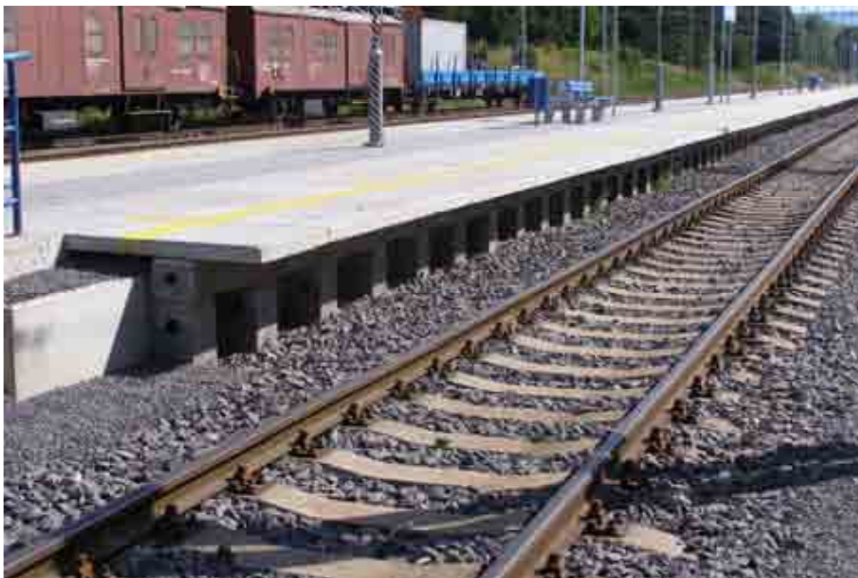
Obrázek 3: Nástupiště č. II (oboustranné s úrovnňovým přístupem)
