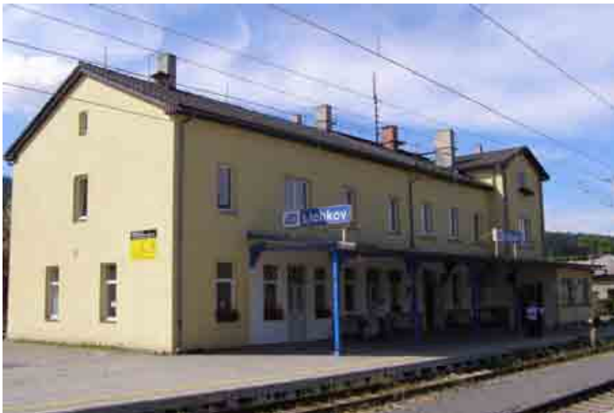
Obrázek 1: Výpravní budova, krytá veranda
