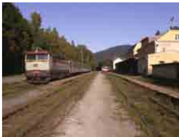
Obr. 3.25 – Jeseník – úrovněná nástupiště
