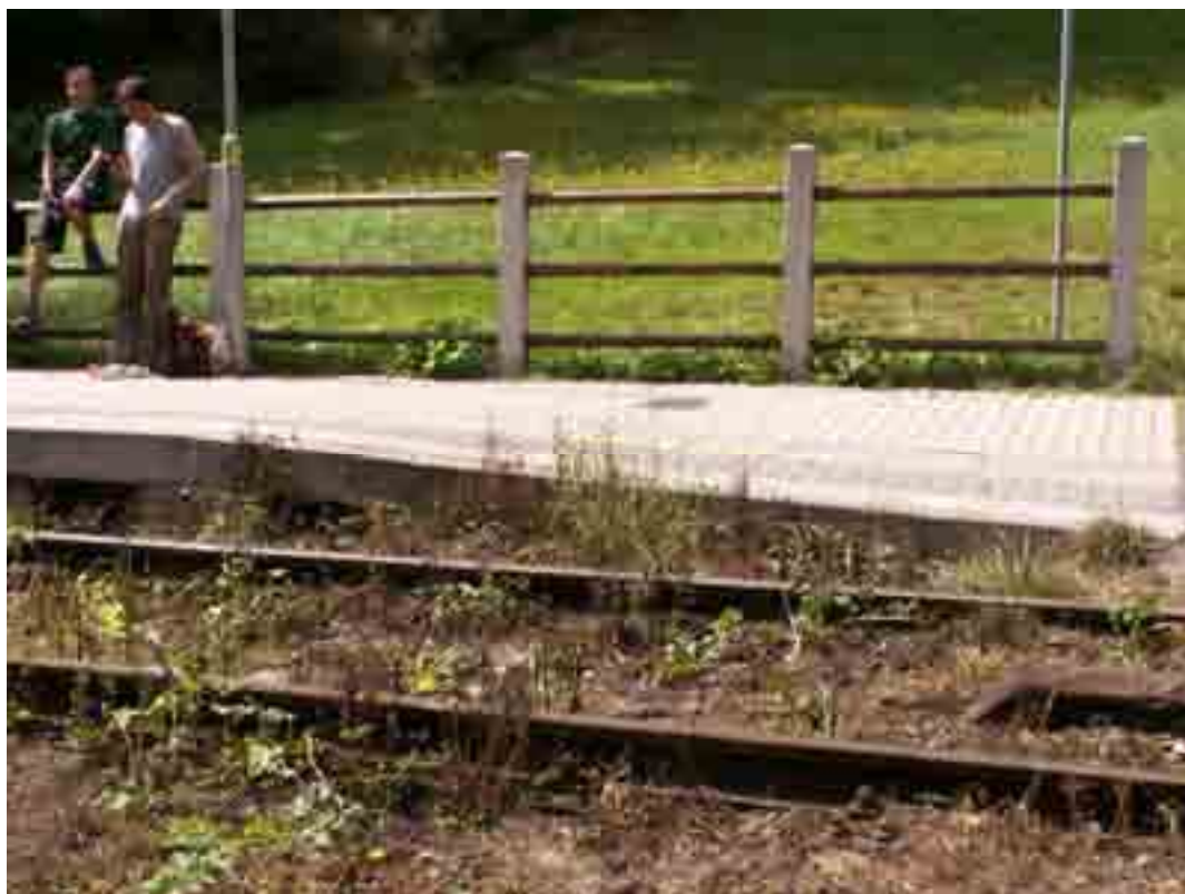
Obrázek 3: Přístup šikmou rampou od pozemní komunikace
