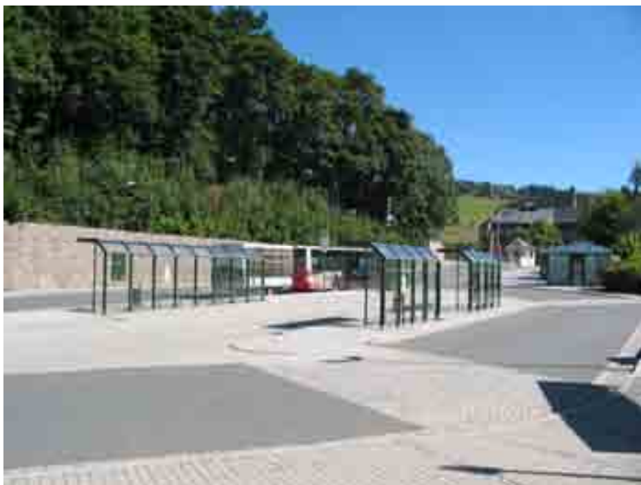
Obrázek 3: Stanoviště autobusů v přednádraží
