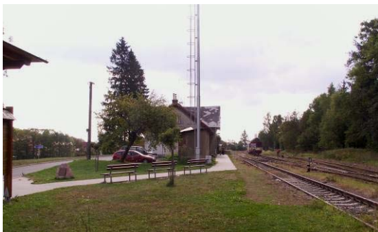
Obr. 3.28 – Rokytnice v Orl. h. – pohled od autobusového terminálu
