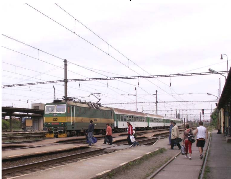
Obr. 3.2 – Úrovňová nástupiště z konzolových desek
