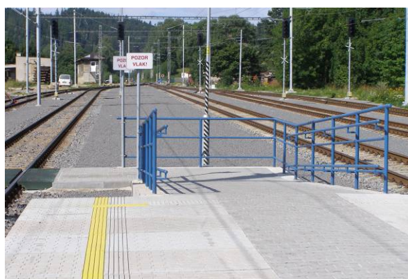
Obr. 3.15 – Šikmá rampa doplněná zábradlím
