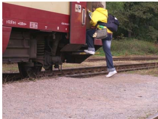
Obr. 3.1 – Úrovňové sypané nástupiště (silně podudržované)
