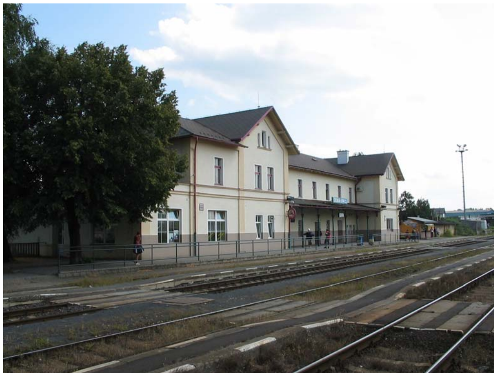
obr. IV.1 – pohled na výpravní budovu
