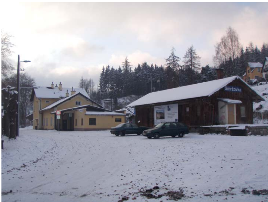
obr. XIII.3 – prostor přednádraží, boční rampa se skladem
