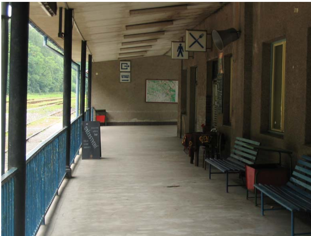
obr. V.3 – přístřešek výpravní budovy
