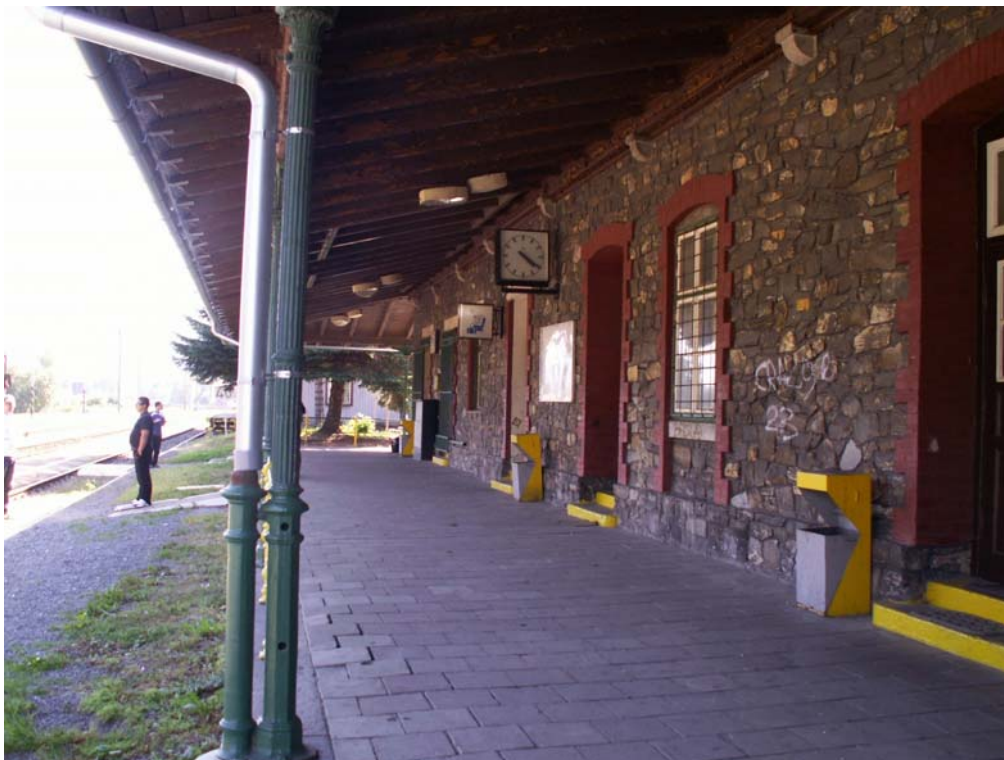
obr. XVII.3 – přístřešek u výpravní budovy
