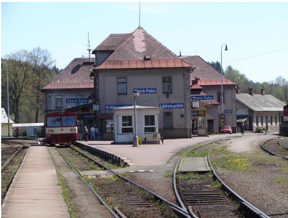
obr. XIV.1 – pohled na výpravní budovu a nástupištní klín
