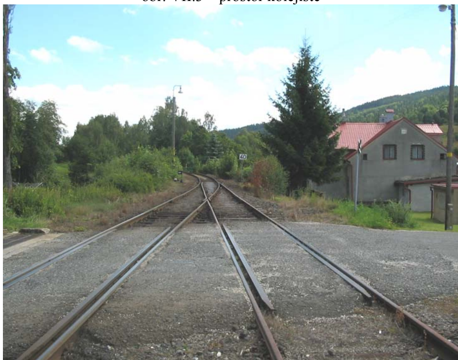
obr. VII.4 – železniční přejezd v prostoru zhlaví
