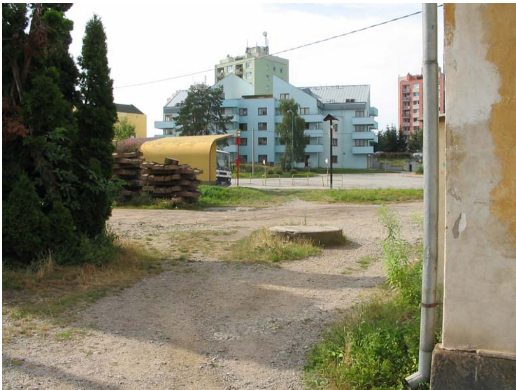
obr. XVI.3 – příchod od výpravní budovy k přednádraží
