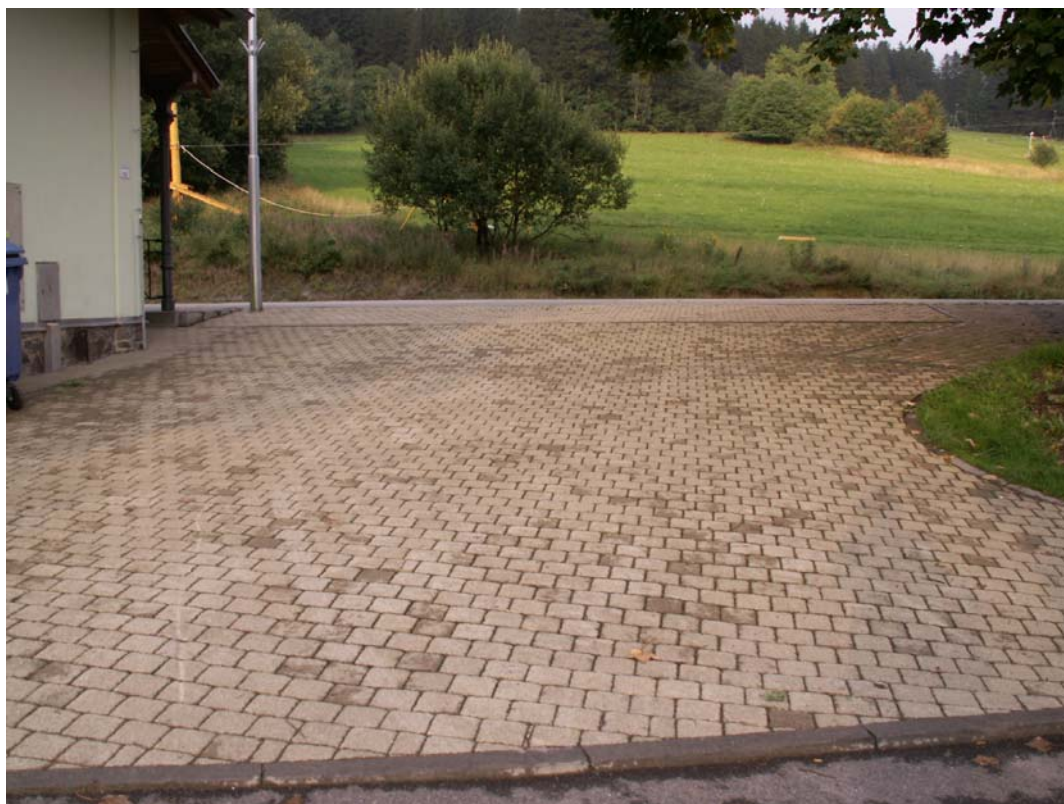
Obrázek 2: Bezbariérový přístup na nástupiště a k budově
