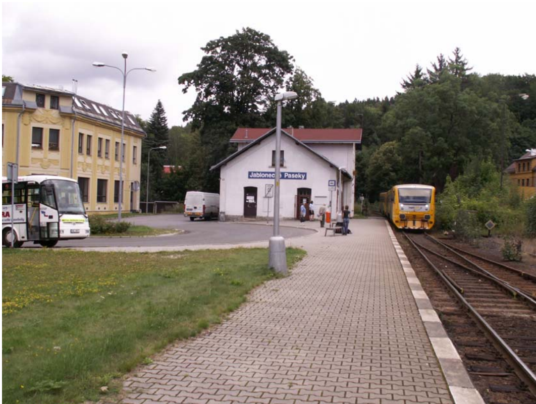
Obrázek 1: Celkový pohled na přestupní bod
