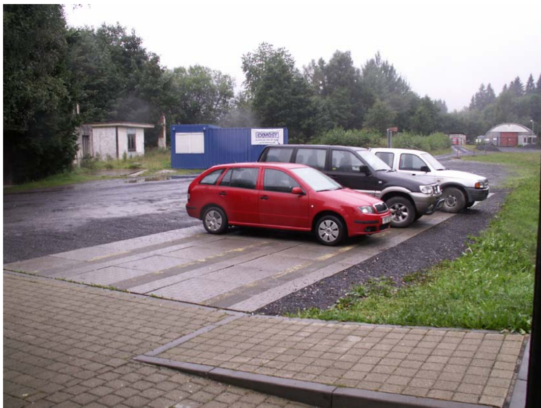
Obrázek 3: Přednádraží, šikmá rampa na nástupiště
