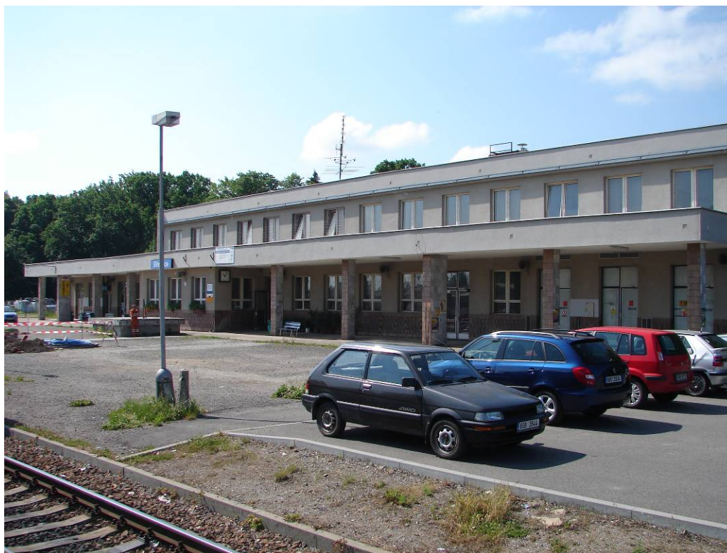
Obrázek 1: Výpravní budova, krytá veranda
