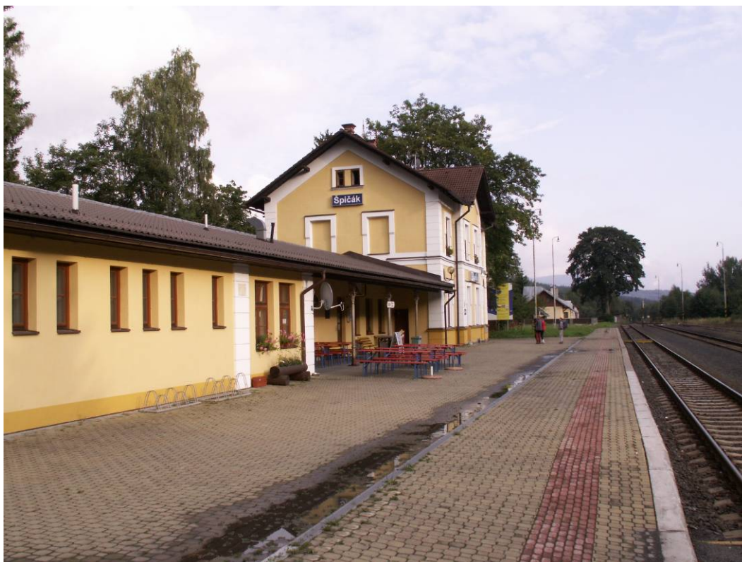
Obrázek 1: Výpravní budova, krytá veranda
