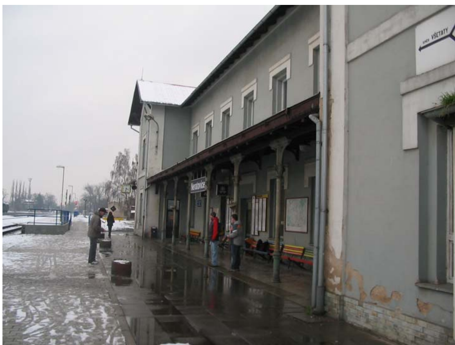
Obrázek 4: Prostor před výpravní budovou
