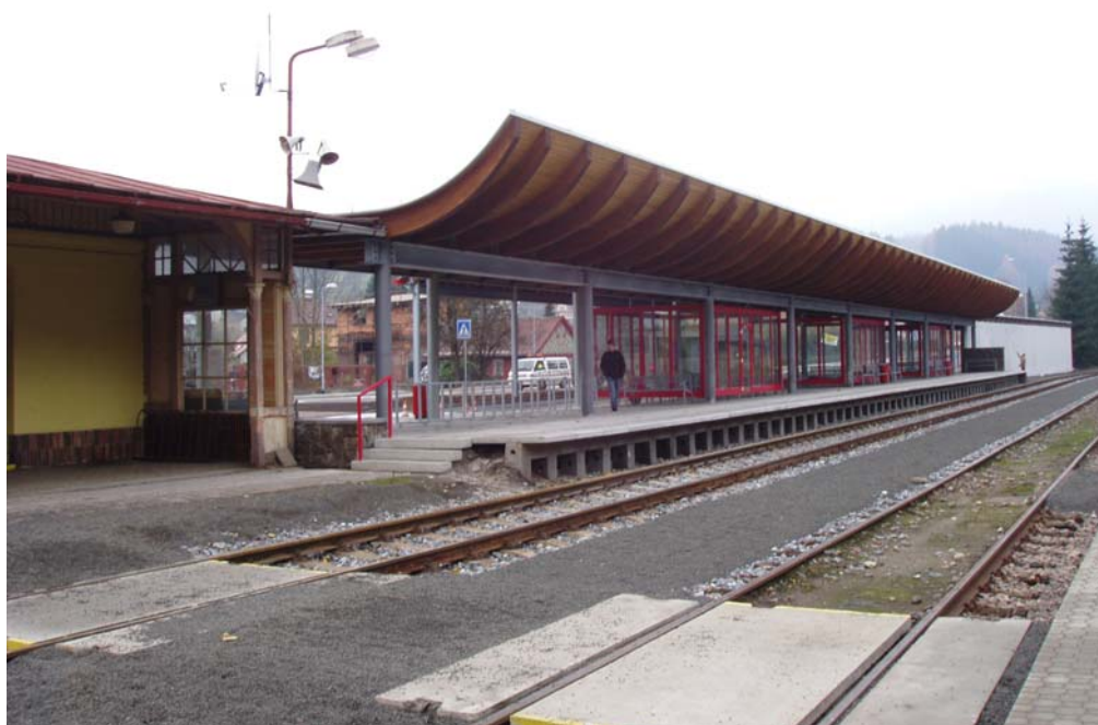
Obrázek 2: Terminál a nástupiště č. I
