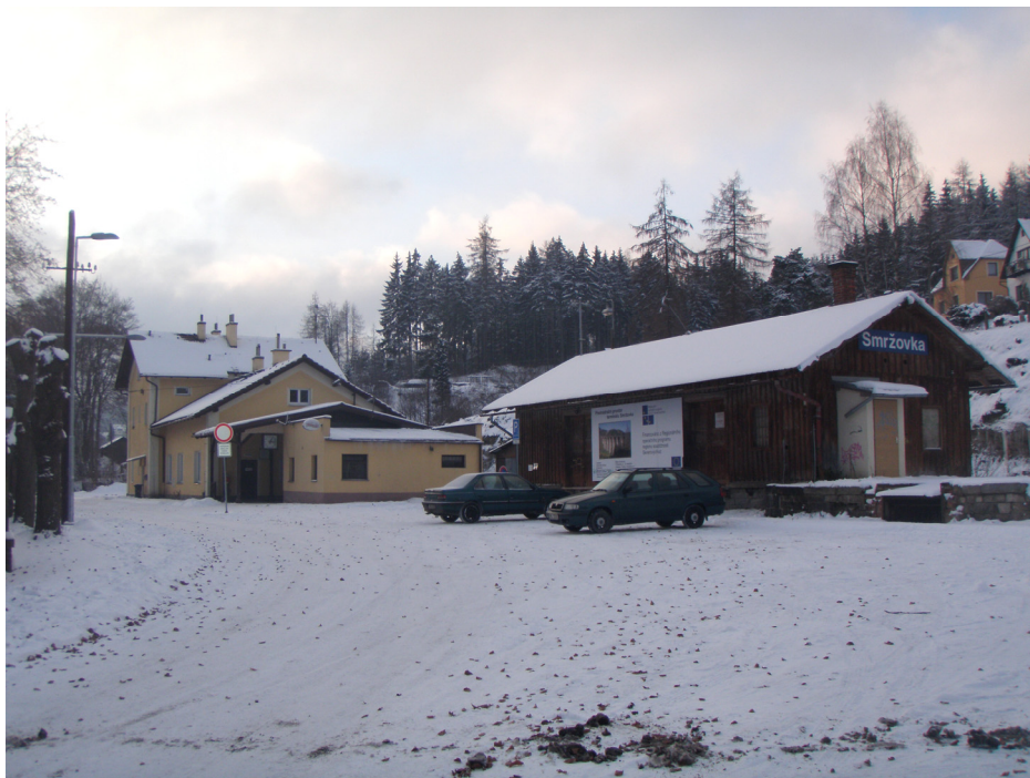
obr. XIII.3 – prostor přednádraží, boční rampa se skladem
