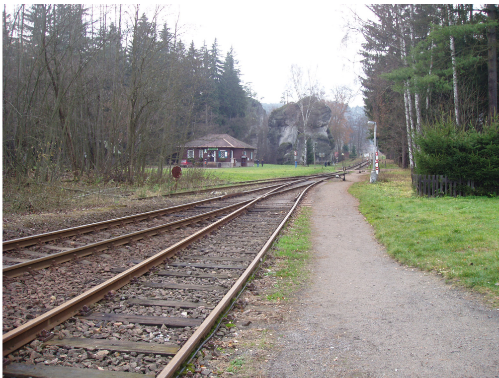
obr. I.3 – pohled na trutnovské zhlaví
