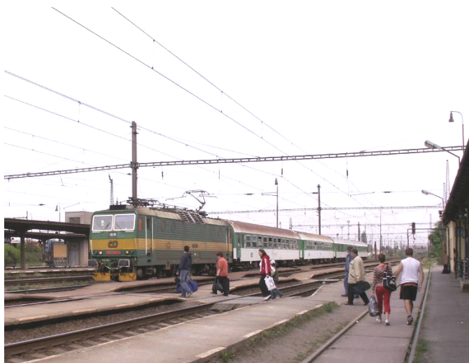
Obr. 3.2 – Úrovňová nástupiště z konzolových desek
