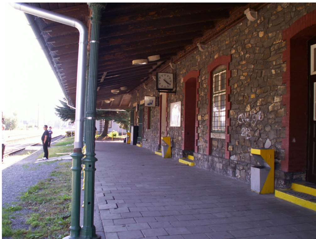
obr. XVII.3 – přístřešek u výpravní budovy
