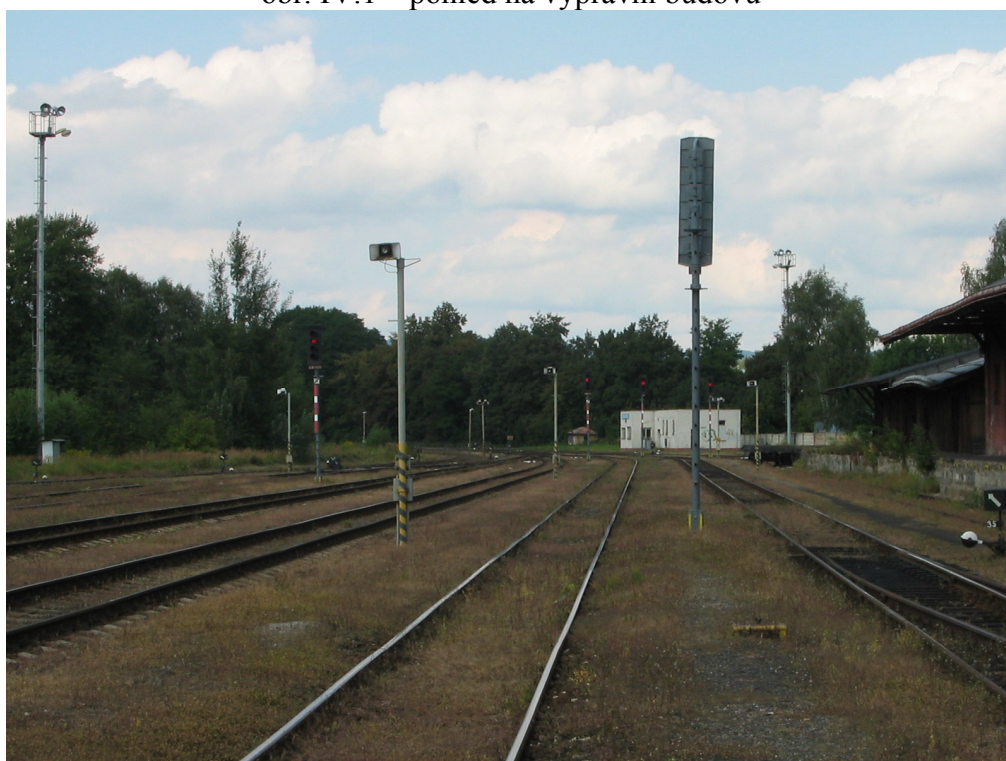
obr. IV.2 – pohled na severní zhlaví
