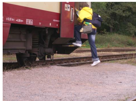
Obr. 3.1 – Úrovňové sypané nástupiště (silně podudržované)
