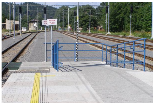
Obr. 3.8 – Šikmá rampa doplněná zábradlím
