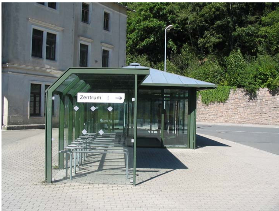
Obrázek 4: Přístřešek pro cestující a jízdní kola
