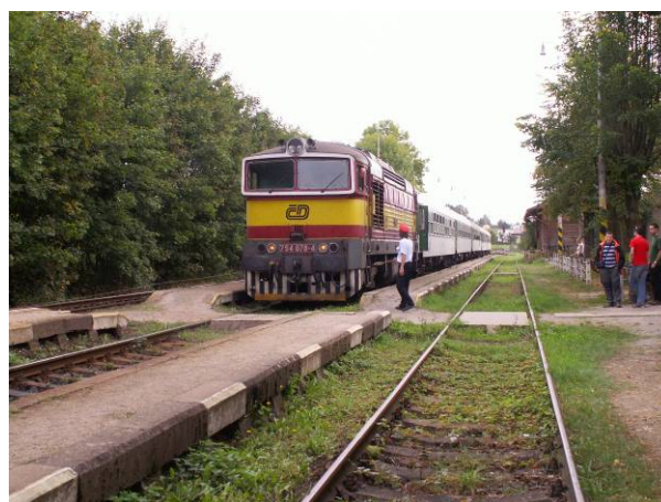
Obr. 3.20 – Potštejn – úrovněná nástupiště
