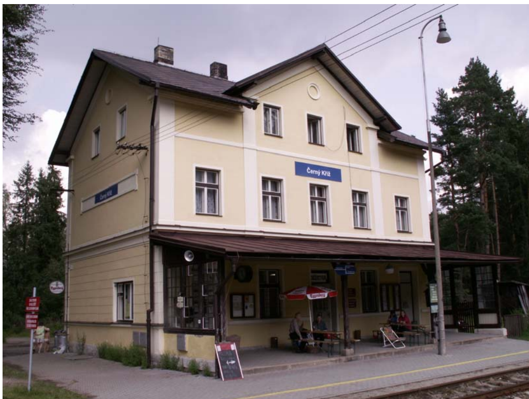
Obrázek 1: Výpravní budova, krytá veranda
