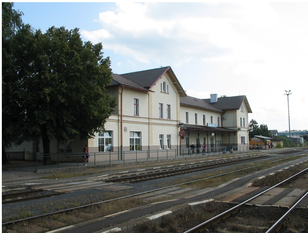
obr. IV.1 – pohled na výpravní budovu
