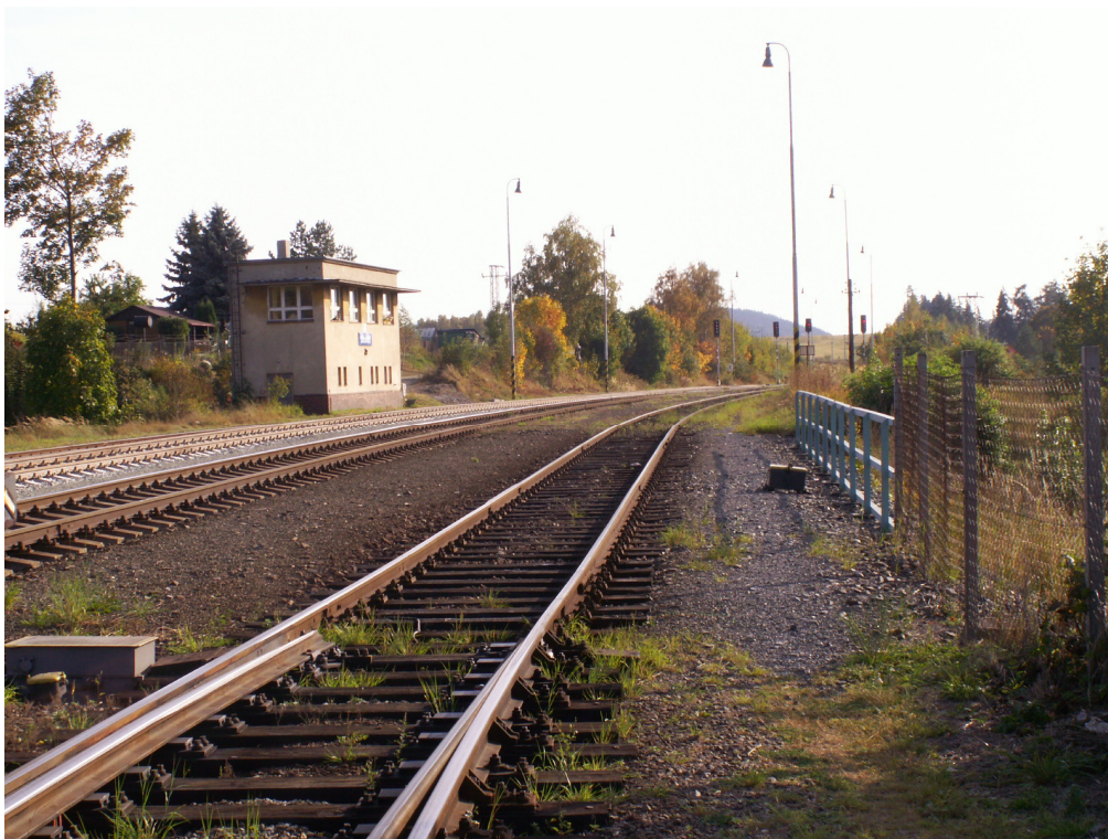
obr. III.3 – pohled na olomoucké zhlaví
