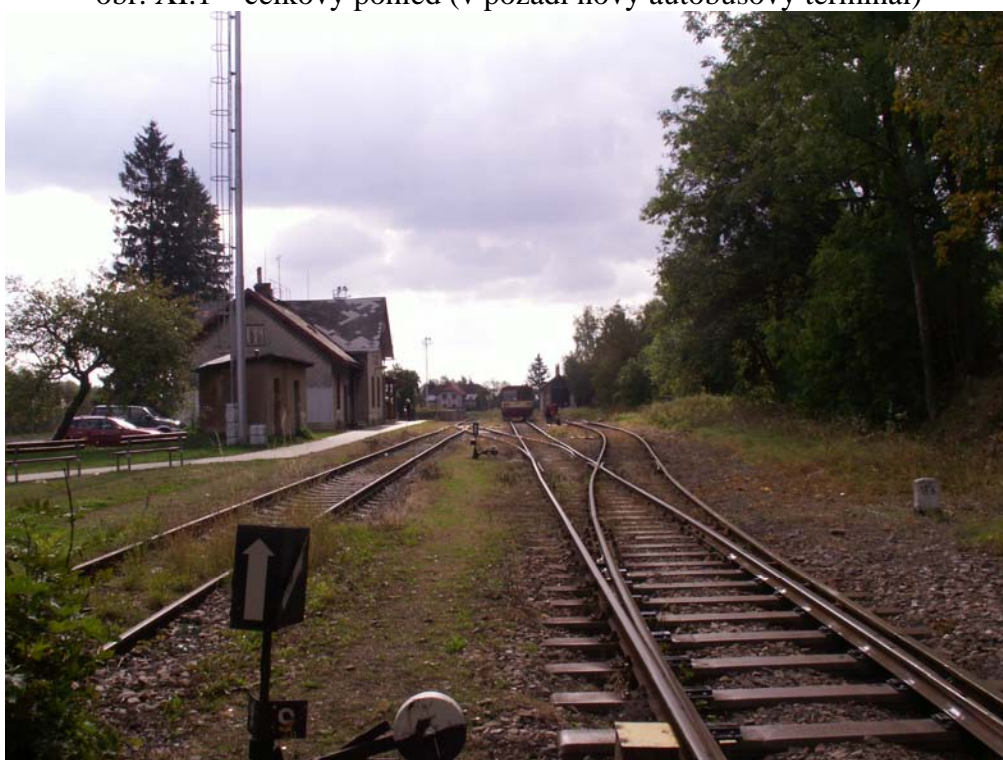
obr. XI.2 – pohled od kusých kolejí severního zhlaví
