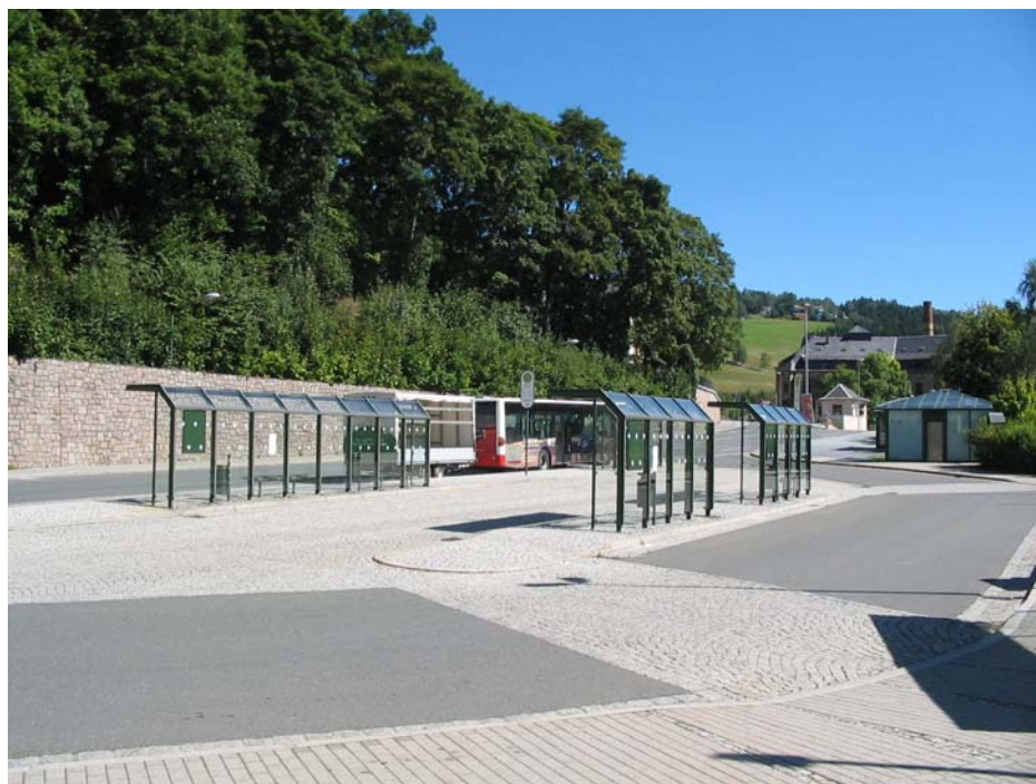
Obrázek 3: Stanoviště autobusů v přednádraží
