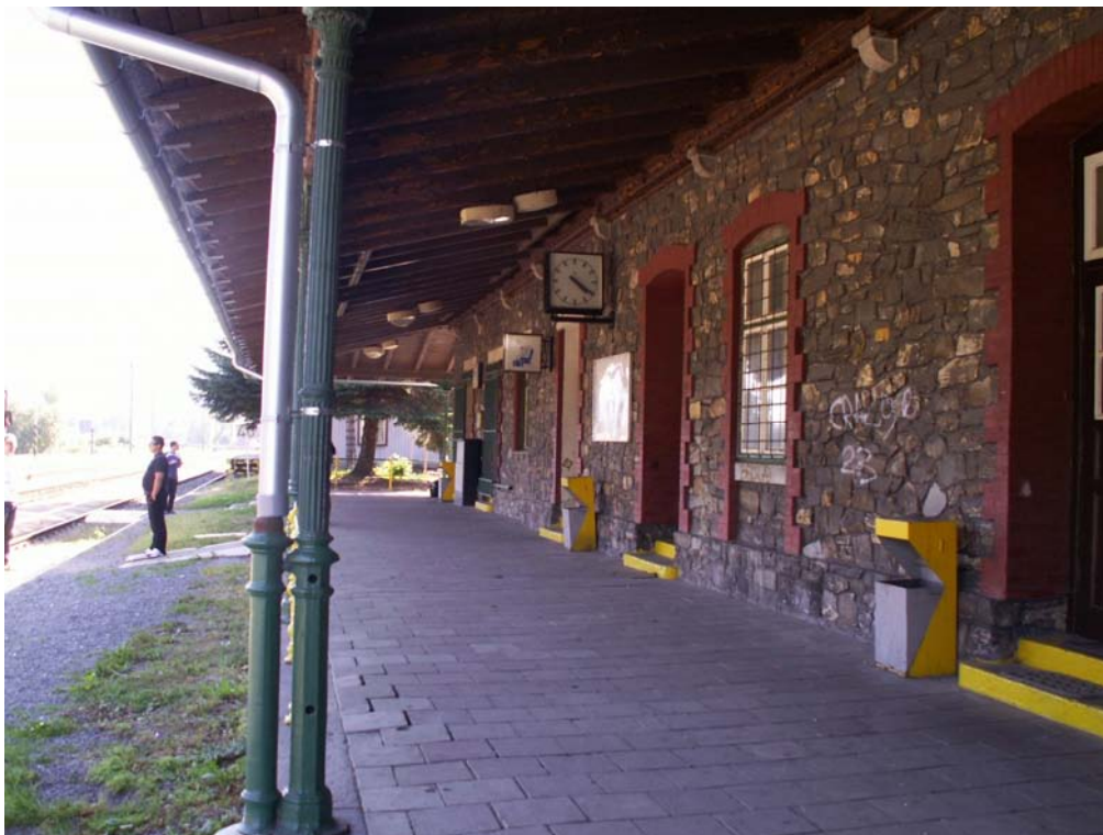
obr. XVII.3 – přístřešek u výpravní budovy
