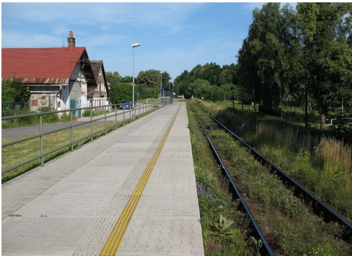
Obrázek 3: Celkový pohled na nástupiště
