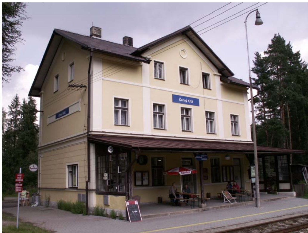
Obrázek 1: Výpravní budova, krytá veranda
