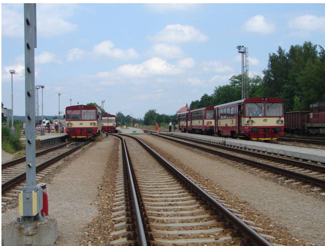
Obrázek 4: Celkový pohled (ze směru Protivín, Strakonice)
