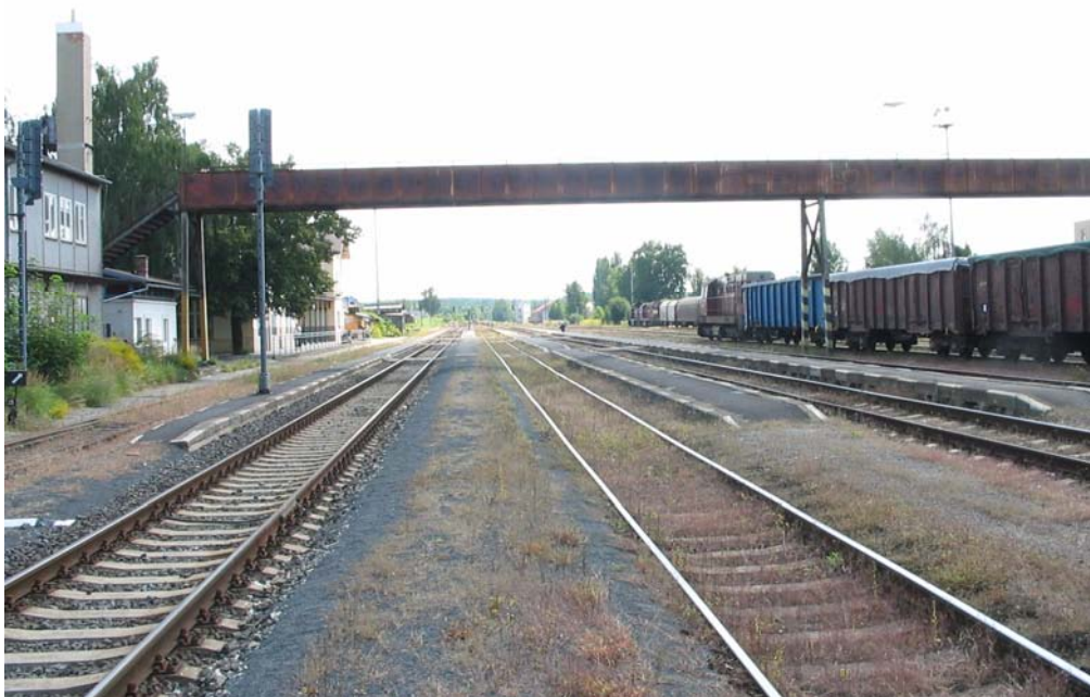
obr. IV.4 – úroňová nástupiště a již nepoužívaná lávka
