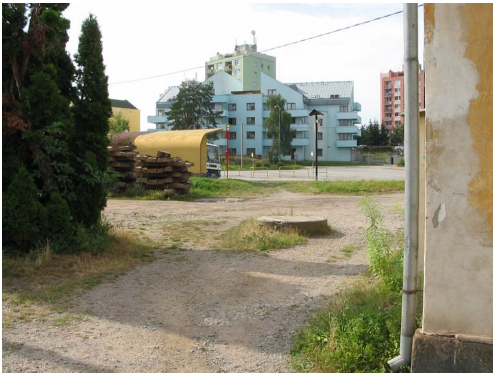
obr. XVI.3 – příchod od výpravní budovy k přednádraží
