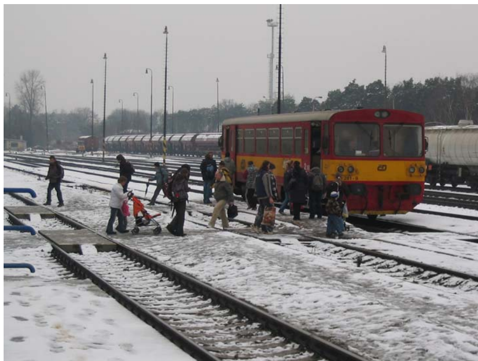
Obrázek 3: Úrovňové přechody na nástupiště č. II, III a IV
