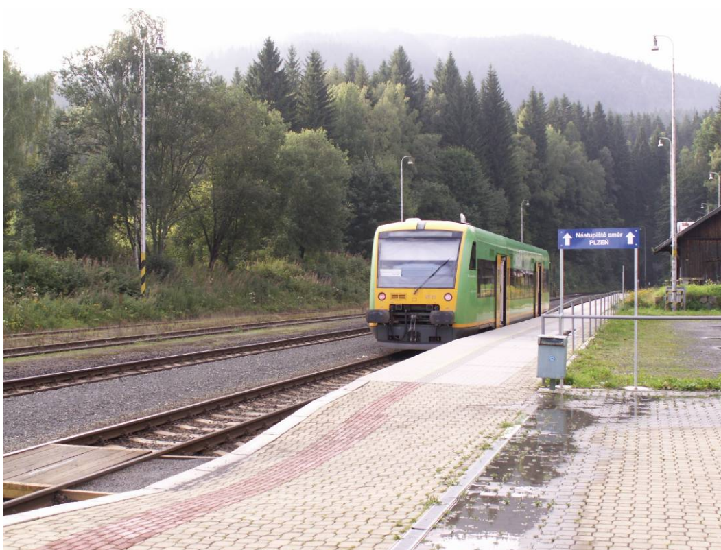
Obrázek 2: Nástupištní předěl – rampa k úrovněmu přechodu
