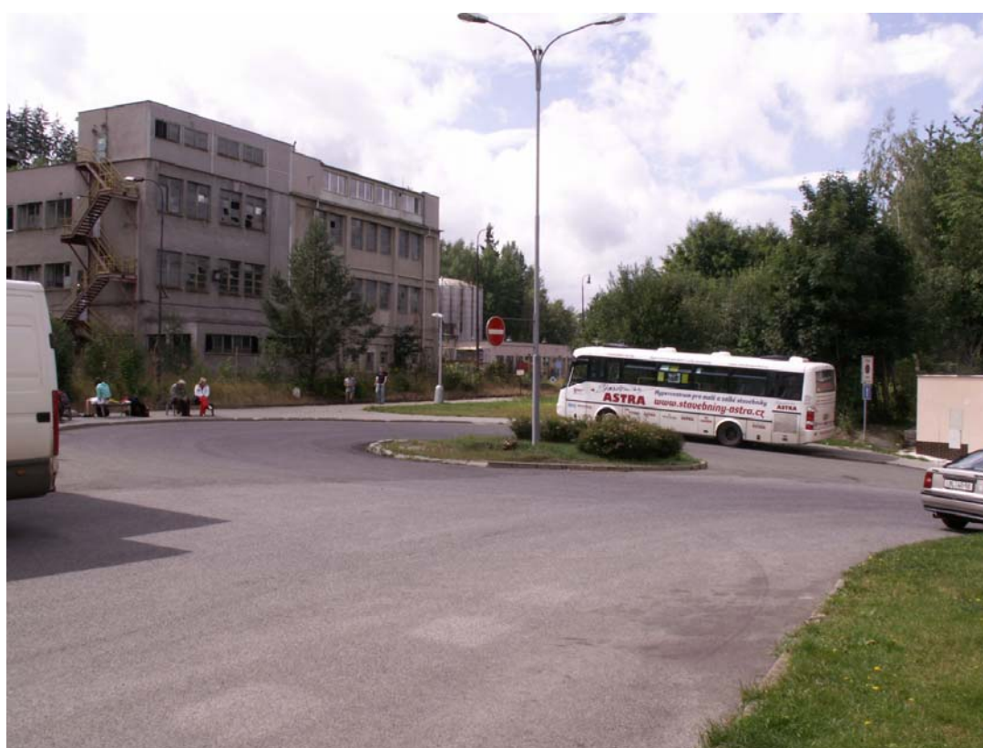
Obrázek 4: Detail obratiště autobusů
