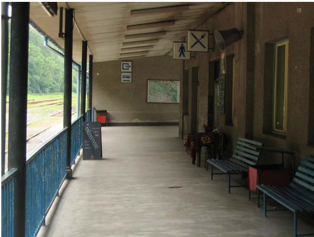
obr. V.3 – přístřešek výpravní budovy
