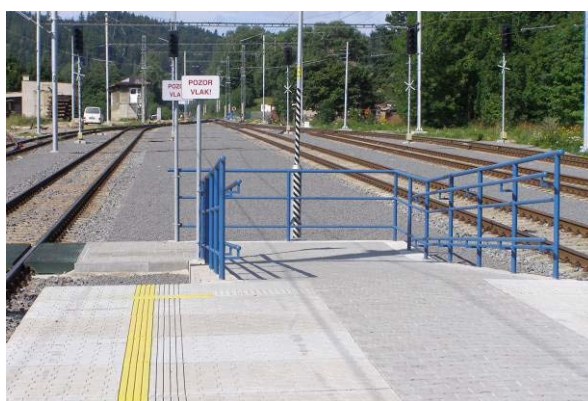
Obr. 3.8 – Šikmá rampa doplněná zábradlím
