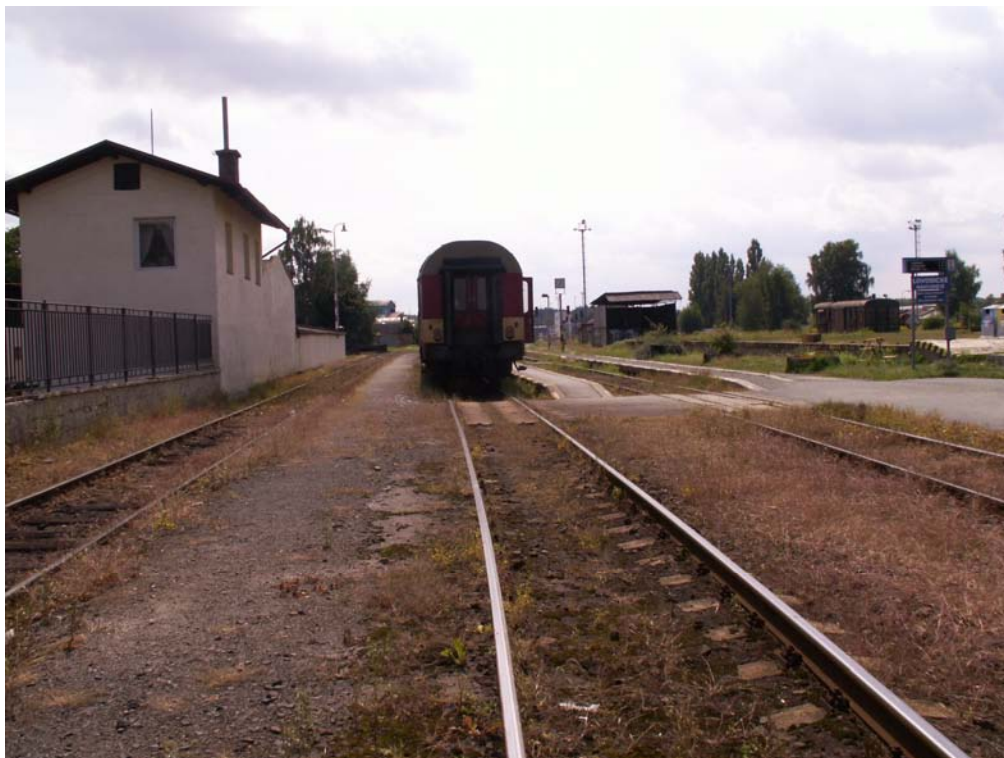
obr. IV.3 – pohled na tzv. „lovosické“ nástupiště (mimo průjezdnou část kolejiště)
