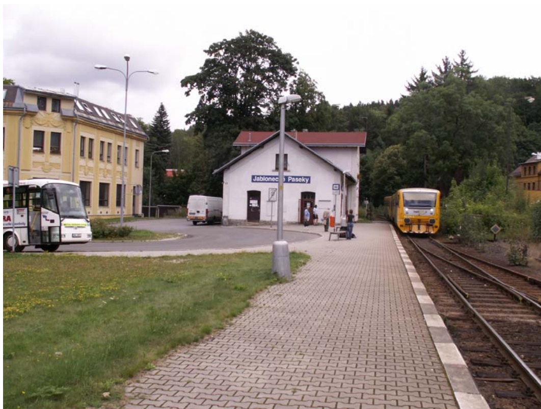
Obrázek 1: Celkový pohled na přestupní bod
