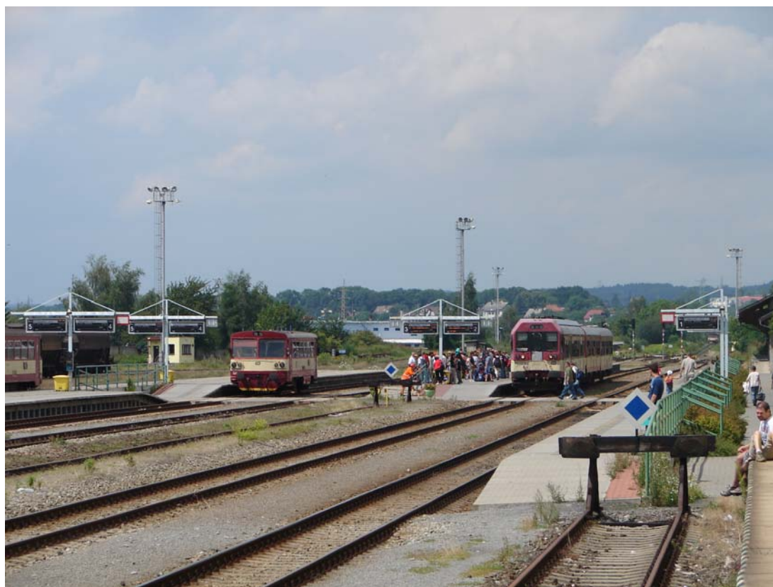
Obrázek 4: Celkový pohled na nástupiště
