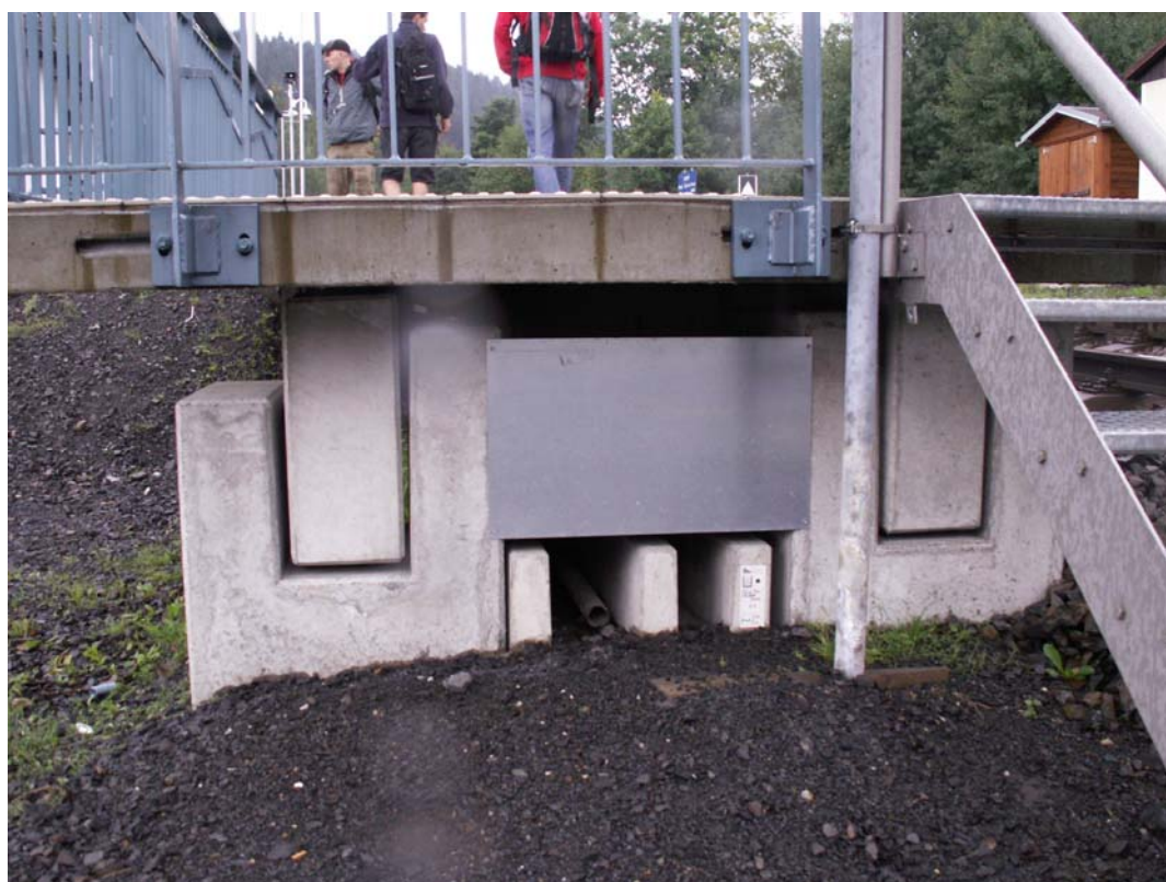
Obrázek 4: Detail konstrukce nástupiště
