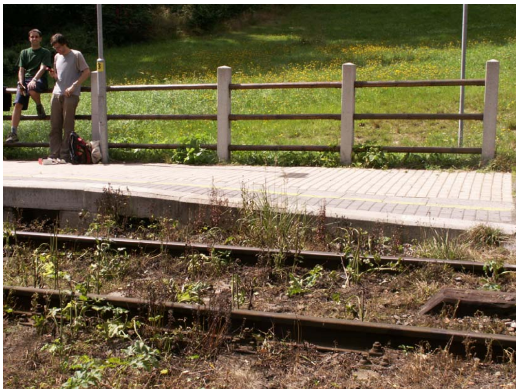
Obrázek 3: Přístup šikmou rampou od pozemní komunikace
