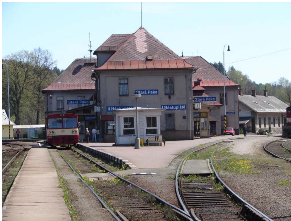
obr. XIV.1 – pohled na výpravní budovu a nástupištní klín
