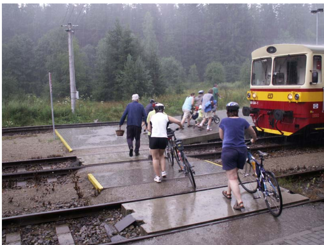
Obrázek 2: Ústřední úrovněový přechod
