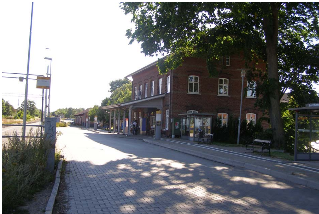
Obrázek 3: Výpravní budova s verandou, autobusové zastávky s přístřešky
