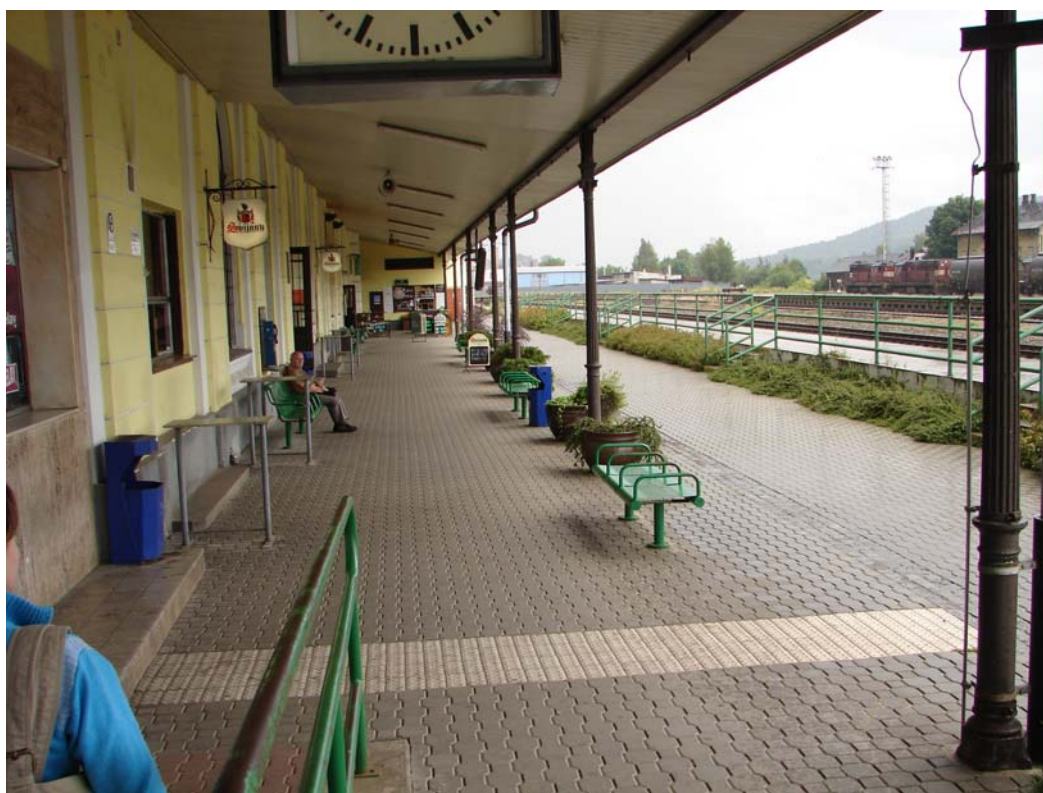
Obrázek 1: Výpravní budova, krytá veranda
