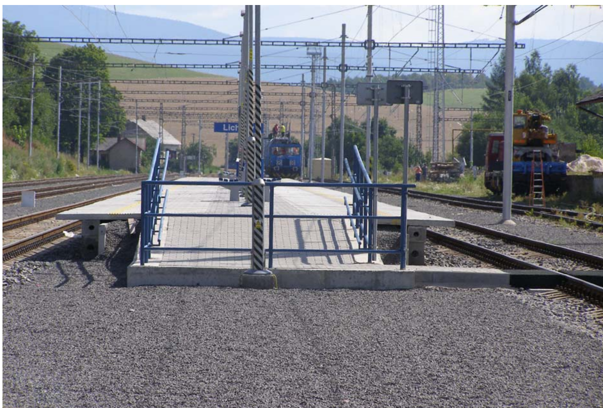
Obrázek 4: Přístup na nástupiště č. II
