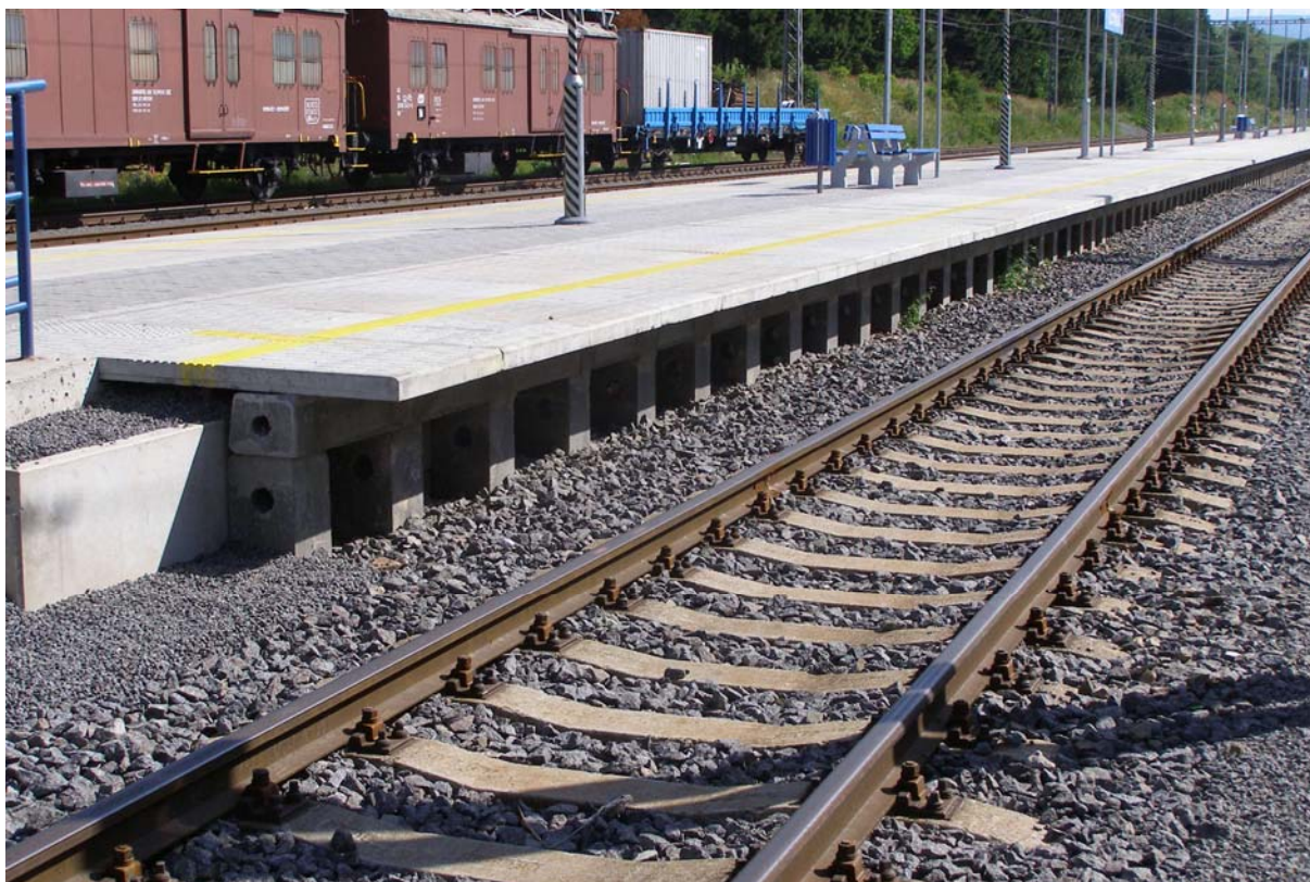
Obrázek 3: Nástupiště č. II (oboustranné s úroňovým přístupem)
