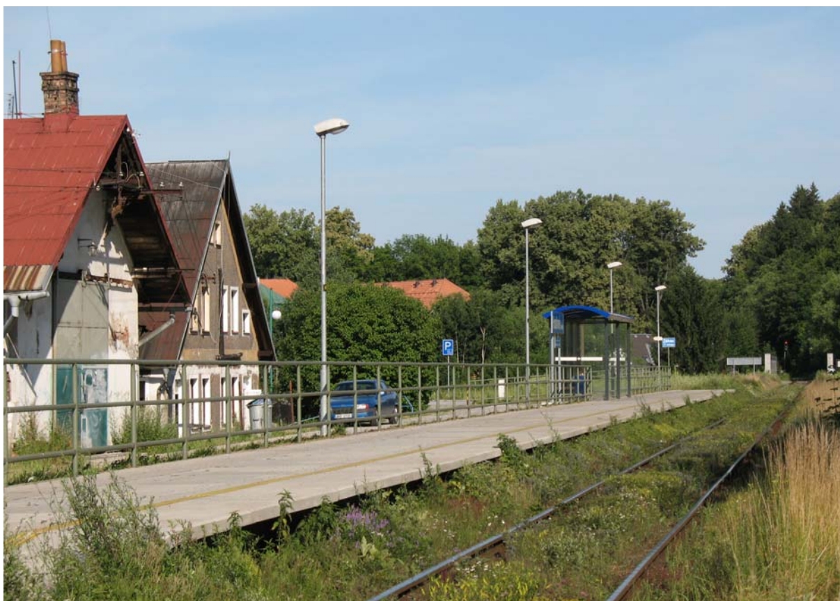
Obrázek 2: Celkový pohled na nástupiště s přístřeškem
