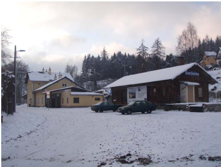
obr. XIII.3 – prostor přednádraží, boční rampa se skladem
