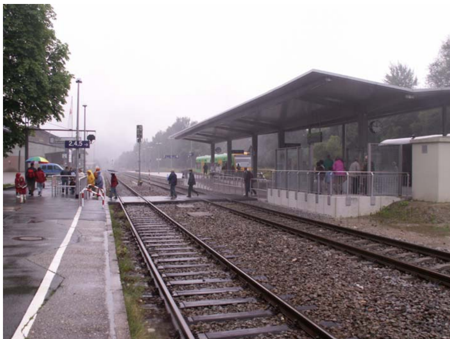
Obrázek 3: Celkový pohled na nástupiště
