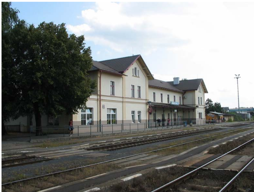
obr. IV.1 – pohled na výpravní budovu
