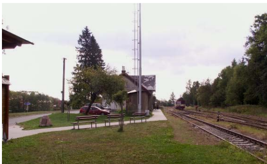
Obr. 3.21 – Rokytnice v Orl. h. – pohled od autobusového terminálu
