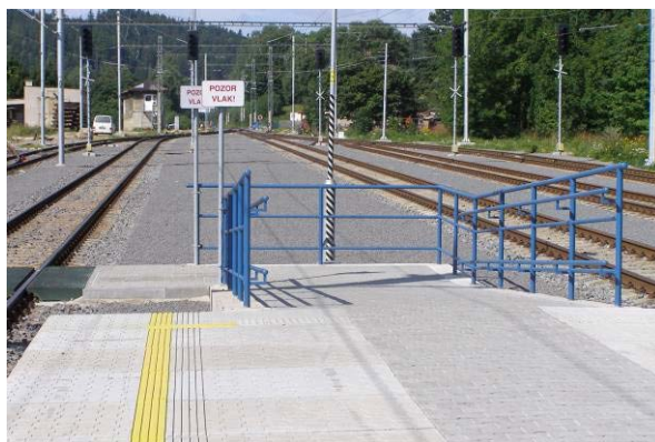
Obr. 3.8 – Šikmá rampa doplněná zábradlím
