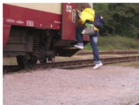
Obr. 3.1 – Úrovňové sypané nástupiště (silně podudržované)
